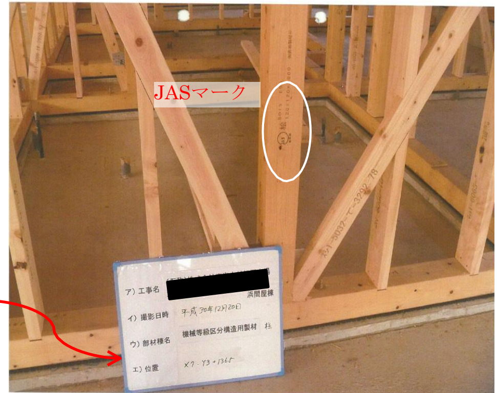
写真 施工写真の例
