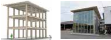
高知県産JAS製材や大断面集成材を使用して建てる中高層木造ビル
