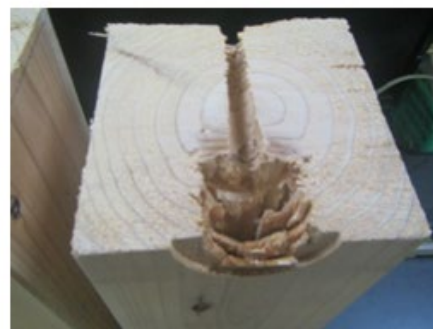
マルチボルト挿入部で鋸断した柱断面
