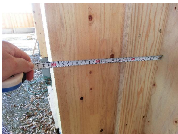
通平柱 構造用集成材：E105-F300 120×300×3980 300 寸法確認
