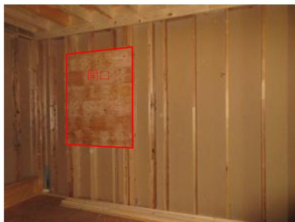
2F 従業員室 X13~8×Y0 通 縦・上下枠・まぐさ・窓台、垂木： JAS 枠組壁工法用製材
