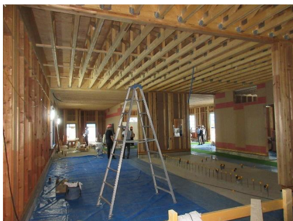
1F 冷蔵庫・トイレ X10~19×Y16~5 通 縦・上下枠、トラス 2×19 組： JAS 枠組壁工法用製材
