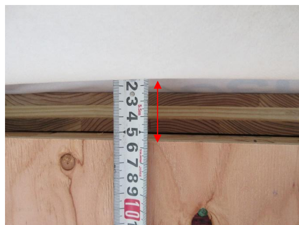
1F 屋根：X1×Y8 通り JAS 構造用 CLT スキ Mx60-3-3 計測 3層3ブレイ 厚 36mm
