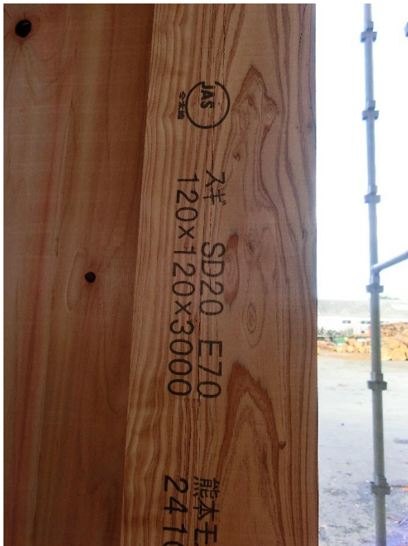
菅柱：機械等級製材 E70 SD20 スギ 120×120×3000
