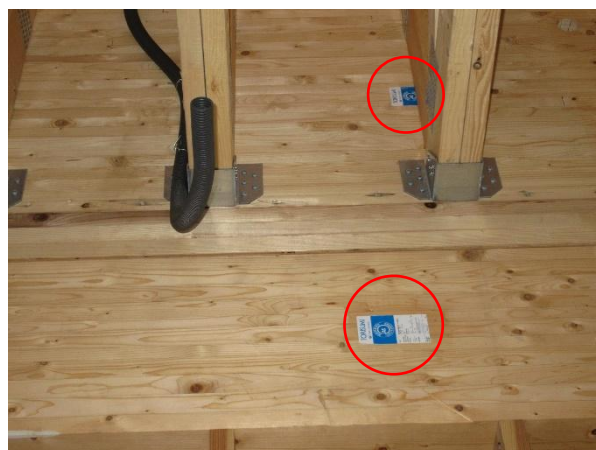
1F 厨房 X20~22×Y16 通 桁：JAS 構造用集 成材 E120-F330 スプルス 140×698 まぐさ：JAS 構造用集成材 E105 スプルス 616
