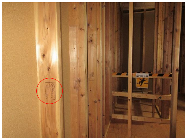
2F 従業員室 X10~7×Y0 通 縦枠：JAS 枠組壁工法用製材 204,206 スギ
