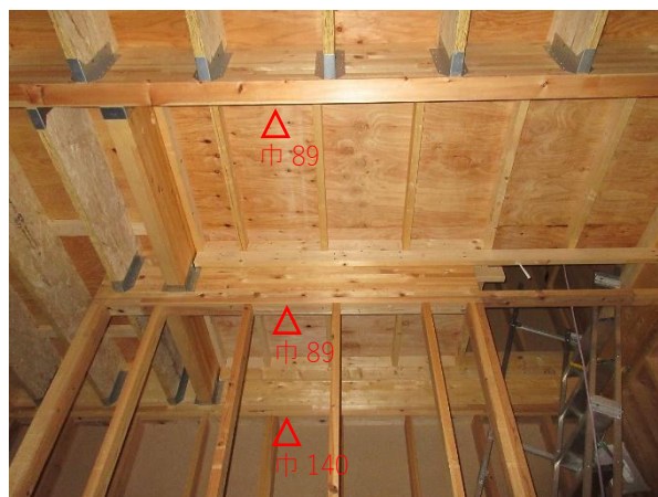
1F 階段室 X7~3×Y3~0 通 床梁：JAS 構造用集成材 E105 スプル 手前 89×356、奥 壁面 140×356
