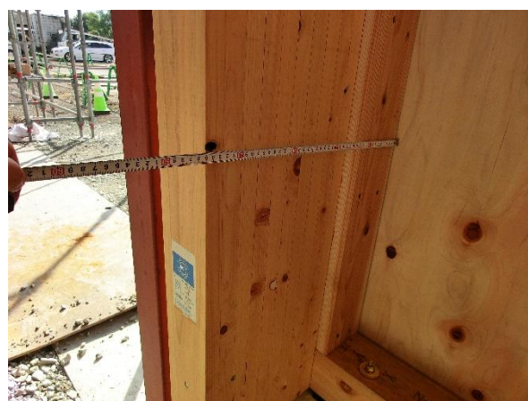
通平柱 構造用集成材 中断面 JAS シール 異等級構成集成材 ウッドエナジー協同組合 420 寸法確認
