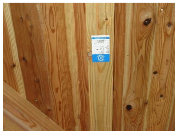
1F 玄関 X3~5×Y1~5 通 梁 105×150：JAS 構造用集成材 ベ イマツ JAS マーク
