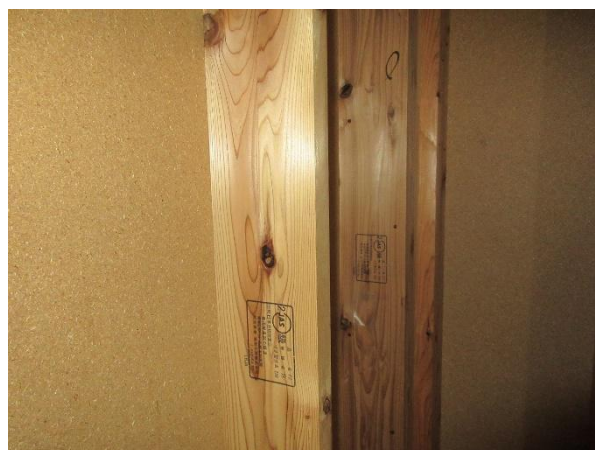
2F 従業員室 X12~13×Y5 通 縦枠： JAS 枠組壁工法用製材 スギ JAS マーク
