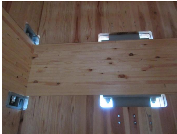
CLT と集成材の接合金物
