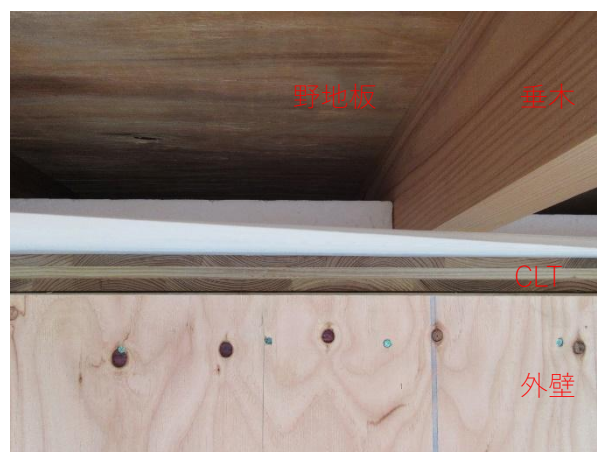
1F 屋根：野地板 JAS 構造用合板 厚 12mm 写真： 外壁+CLT 板+垂木+野地板
