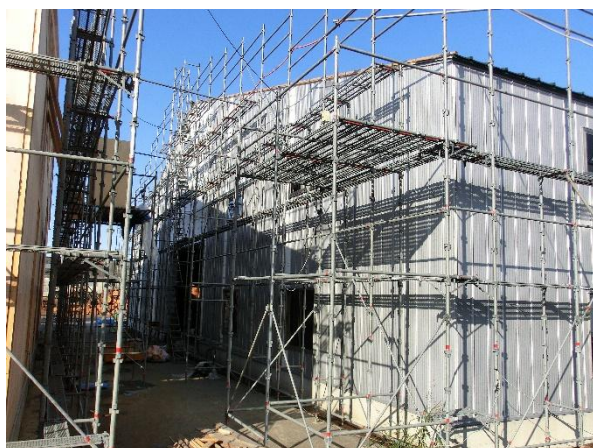
外壁 施工中 右側は西棟
