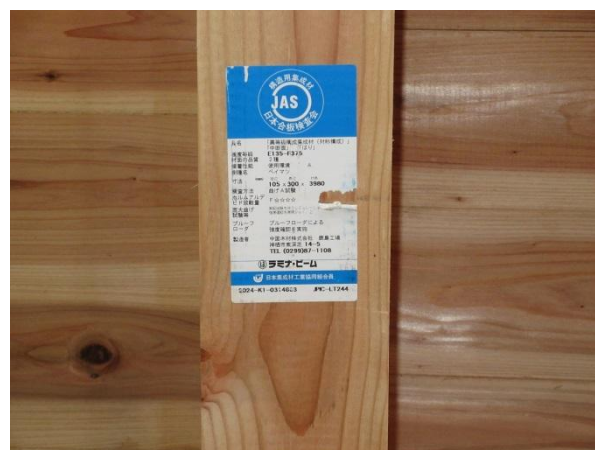
1F ATMコーナー・窓口ロビー X5 通× Y3~6 通 梁 105×300 ベィマツ： JAS 構造用集成材 JAS マーク
