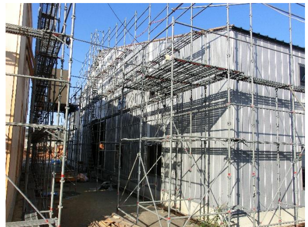
右側 東棟西面 外壁仕上げ：ガルバリウム鋼板
