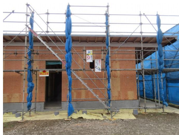
外観 北東側より
