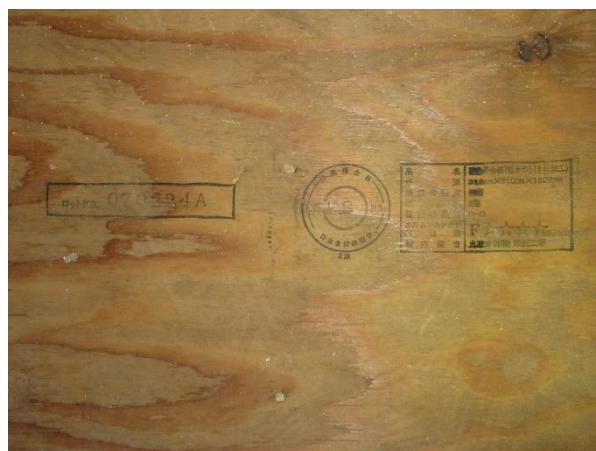
2F 従業員室 X8×Y4 通 床：JAS 構造用合板 t24 JAS マーク
