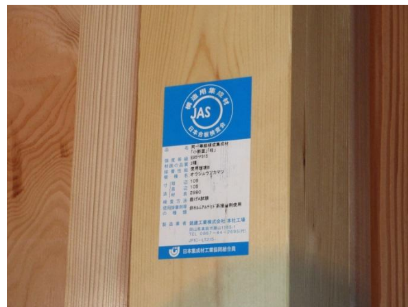
1F 事務室・廊下 X5×Y10 通 柱 105×105 オッシュアカマツ： JAS 構造用集成材 JAS マーク
