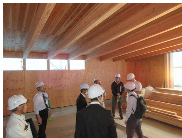
1F 事務室～窓口ロビー 内観 X5~12 通×Y10~1 通
