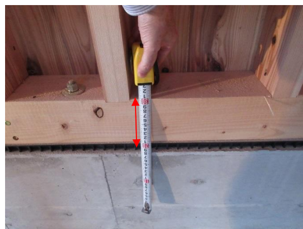
1F 事務室・廊下 X5×Y10~11 通 土台 105×105 ヒノキ：JAS 機械等級製材 目視+聴取+寸法計測
