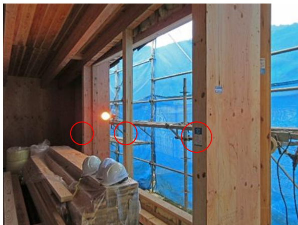
1F 窓口ロビー X5~12×Y1~6 通 柱 オウシュウアカマツ・梁 ペイマツ： JAS 構造用集成材
