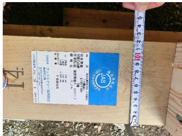
土台：120 寸法 小断面 JAS シール確認 異等級構成集成材 ウッドエナジー協同組合
