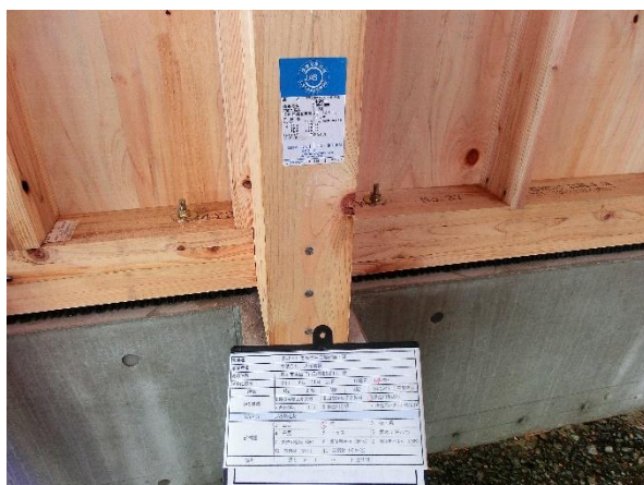
通平柱 構造用集成材：E105-F300 120×300×3980
