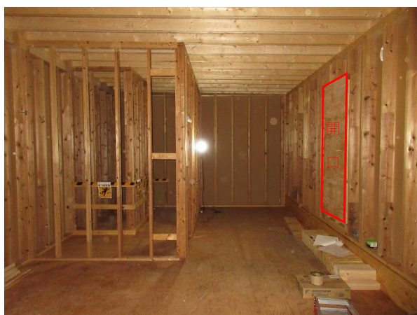
2F 従業員・階段室 X10~3×Y0~5 通 縦・上下枠・まぐさ・窓台、垂木： JAS 枠組壁工法用製材
