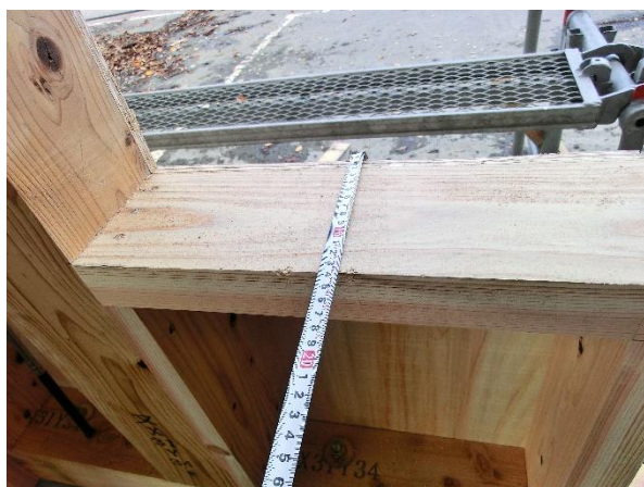
窓台：目視等級製材 杉 45×120 120 寸法確認
