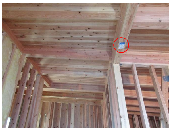
1F ATMコーナー・窓口ロビー X3~7 通 ×Y4~10 通 柱 オッシュアカマツ、 梁 ベィマツ：JAS 構造用集成材 屋根：JAS 構造用 CLT スギ
