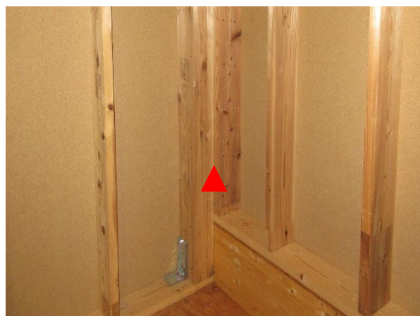
2F 従業員室 X3×Y5 通 柱：JAS 構造用集成材 E105-F345 スプルース 606
