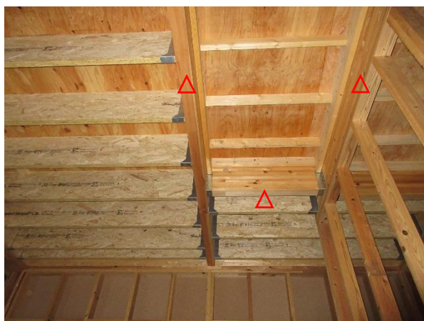
1F 階段室 X4~6×Y3~1 通 床梁：JAS 構造用集成材 E105 スプル 89×356 ※LSL356 は対象外
