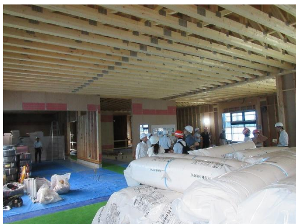
1F 客席 X30~19×Y0~9 通 トラス：JAS 枠組壁工法用製材 3本1組で31組
