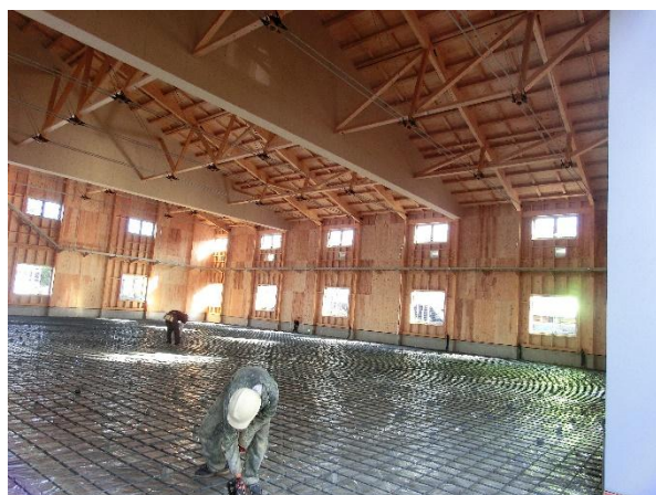
土間 メッシュ敷 D13 施工中
