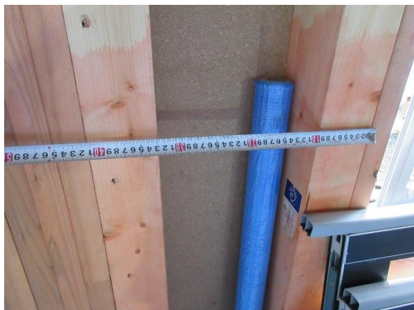
1F 客席 X24×Y0 通あたり 柱：JAS 構造用集成材 E105-F345 スプルス 406×2 JAS マーク、計測
