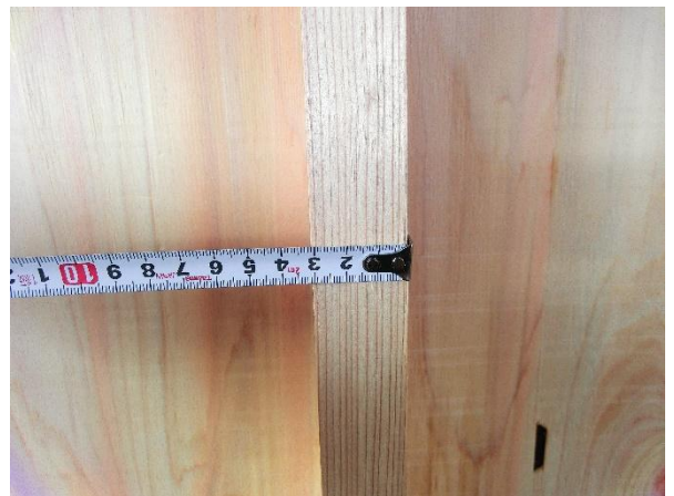
間柱：目視等級製材 杉 30 確認
