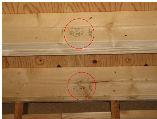
2F 階段室 X7×Y1~2 通 垂木 208： JAS 枠組壁工法用製材 SPF JAS マーク
