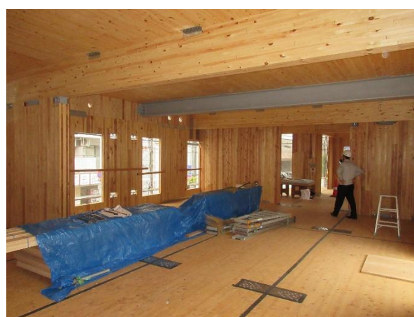
2階 事務室 内観 (写真 32) CLT 床 最大約 10m 長×2m 巾
