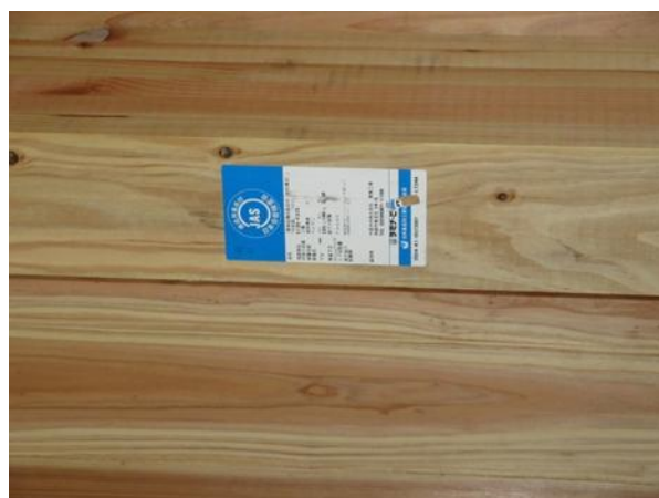
1F 廊下 X1~5×Y9 通 梁 105×180 べ イマツ： JAS 構造用集成材 JAS マーク
