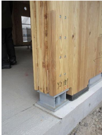
CLT：基礎との接合金物
