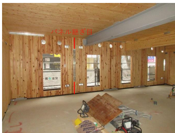
1 階 店舗 内観 (写真 21) 大判パネル 約 7m 巾×3m 高
