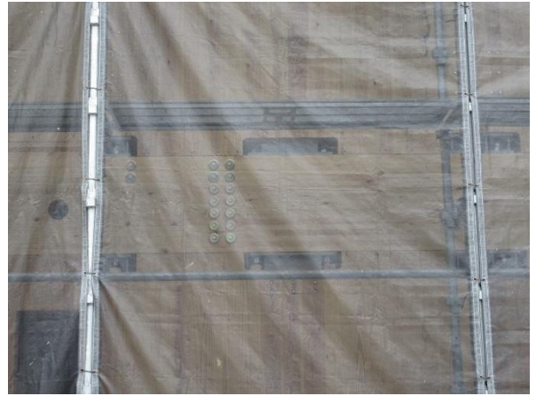
CLT と集成材の接合金物
