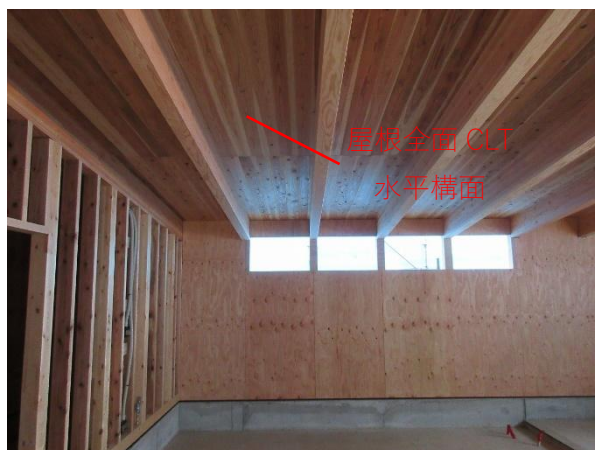
1F 事務室 X5~12×Y11~6 通 屋根：JAS 構造用 CLT スキ Mx60-3-3 柱 オッシュウアカマツ 梁 ペイマツ： JAS 構造用集成材
