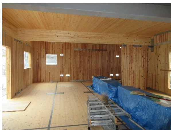
2階 事務室 内観 (写真 26)
