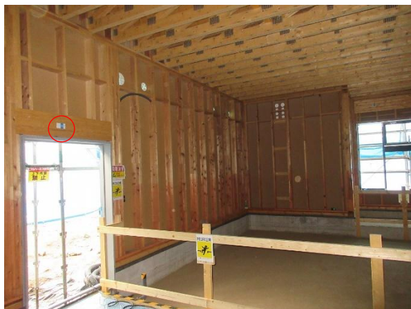
1F 倉庫・冷凍庫 X3~8×Y6~14 通 縦・上下枠、トラス：JAS 枠組壁工法用製材 まぐさ：JAS 構造用集成材 E105 スプル 612
