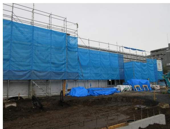
外観 西側より
