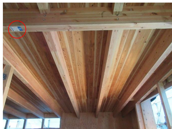
1F 窓口ロビー X5~12×Y6~1 通 屋根：JAS 構造用 CLT スキ Mx60-3-3 柱 オッシュウアカマツ 梁 ペイマツ： JAS 構造用集成材
