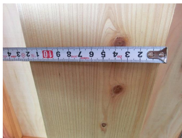
通平柱 構造用集成材：E105-F300 120×300×3980
