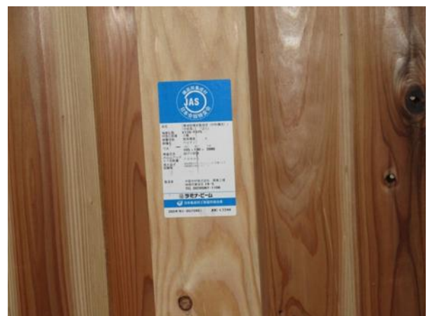
1F 休憩室 X1~5×Y11 通 梁 105×180 ベイマツ：JAS 構造用集成材 JAS マーク 屋根：JAS 構造用 CLT スギ
