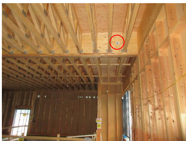
1F 冷蔵庫 X13~3×Y11~16 通 梁：JAS 構造用集成材 E120-F330 スプルス 140×659
