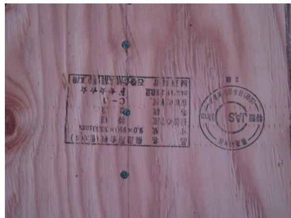
1F 内壁下地： JAS 構造用合板 厚 9mm JAS マーク 石巻合板（株）
