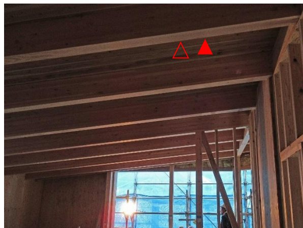
1F 事務室・窓口ロビー X12~5×Y9~1 通 梁（化粧）105×270 べ イマツ： JAS 構造用集成材 寸法計測+聴取
