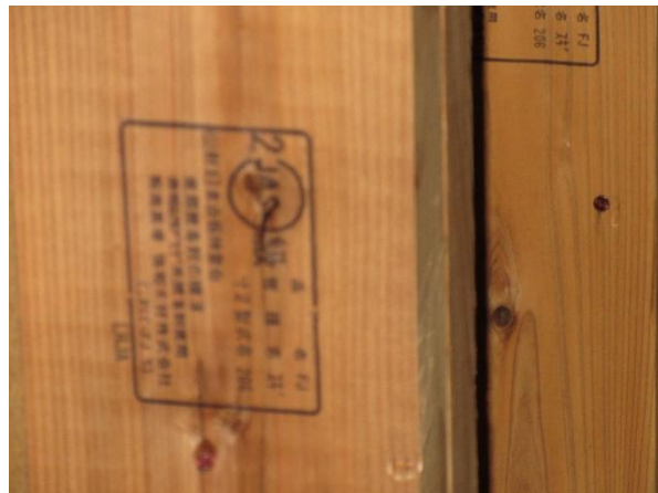
2F 従業員室 X8×Y0 通 縦枠： JAS 枠組壁工法用製材 スギ JAS マーク
