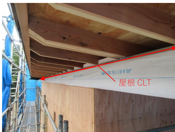
1F 屋根（全面）：X1~12×Y1~13 通り 水平構面：JAS 構造用 CLT スキ Mx60-3-3
