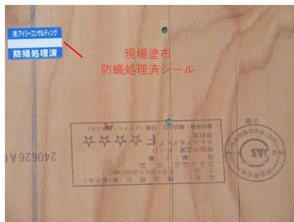
1F 外壁下地： JAS 構造用合板 厚 9mm JAS マーク (株) 日新
