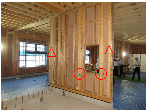
1F トイレ X16~19×Y5~11 通 柱： JAS 構造用集成材 E105-F345 スプルス 606×2本 406×2本
