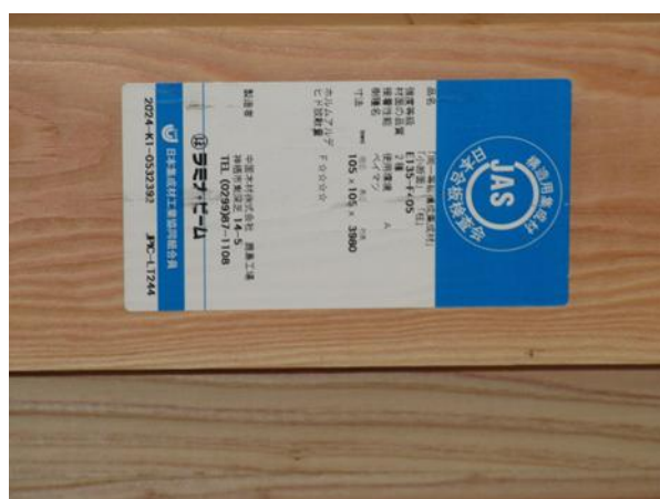
1F 便所 X1~3×Y7 通 梁 105×105 べ イマツ： JAS 構造用集成材 JAS マーク
