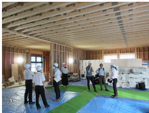
1F 客席 X20~34×Y1~10 通 トラス：JAS 枠組壁工法用製材、梁：JAS 構造用集成材 E120-F330 スプルス 140×698
