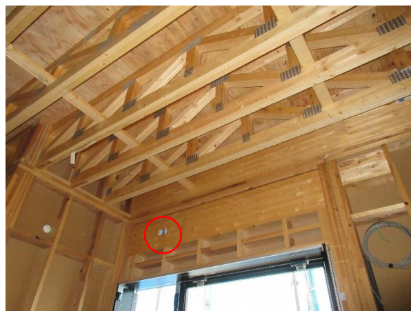
1F 冷凍庫 X6~10×Y14~16 通 まぐさ：JAS 構造用集成材 E105 スプルス 616
