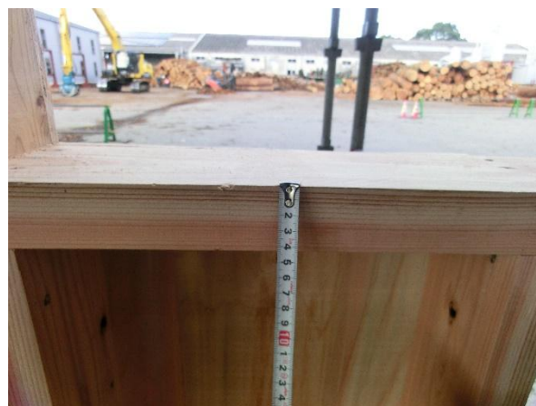
窓台：目視等級製材 杉 45×120 45 寸法確認
