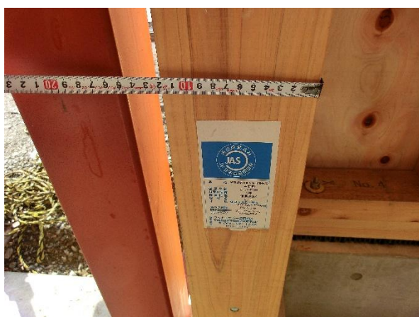
通平柱 構造用集成材：E105-F300 120×420×9000 120 寸法確認
