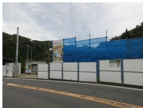
道路側 工事表示板と仮囲い
