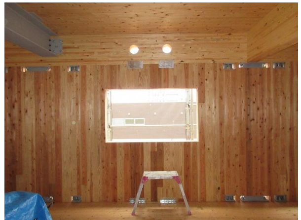
CLT 壁パネル：接合金物
