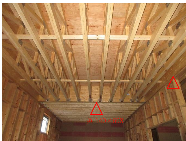
1F パーティールーム X17~8×Y0~5 通 トラス：JAS 桢組壁工法用製材、梁：JAS 構造用集成材 E120×F330 スプルス 140×698
