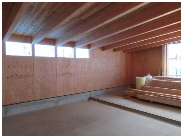
1F 事務室・窓口ロビー X12~5×Y10~1 通 梁（化粧）105×270 べ イマツ： JAS 構造用集成材
