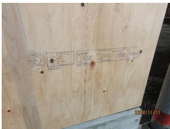
外壁：JAS 構造用合板 JAS 印字 確認 ヒノキ 12
