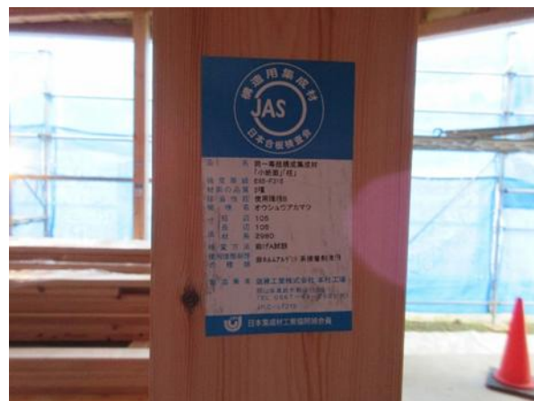
1F 事務室・窓口ロビー X6×Y6 通 柱オッシュアカマツ：JAS 構造用集成材 JAS マーク
