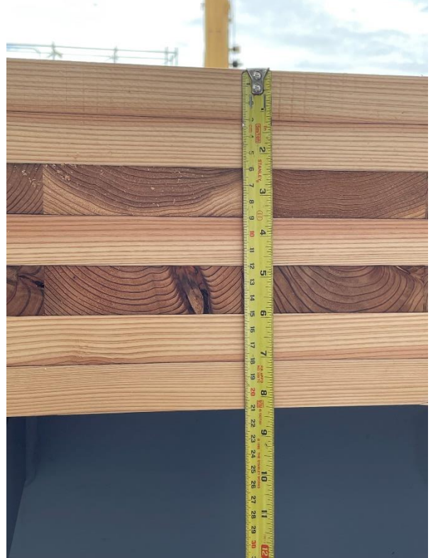
Y3 通り 床_断面部分/寸法 CLT
