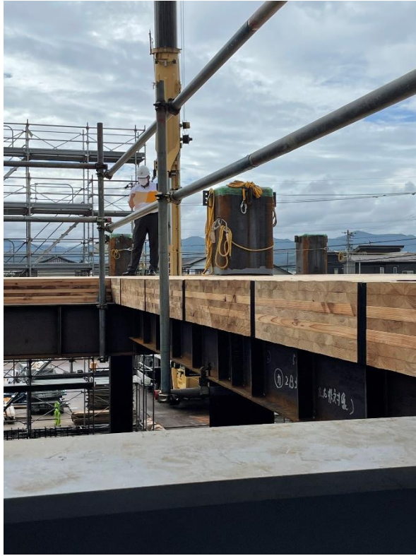
Y3 通り 床_面部分 CLT
