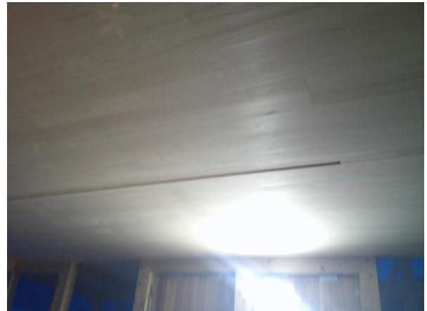
2階 天井面 CLTパネル スリットはライティングレール用
