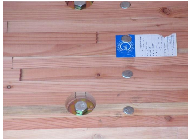
1階 19~22 通×み通 JAS 構造用集成材 150×390 合せ梁 カラマツ
