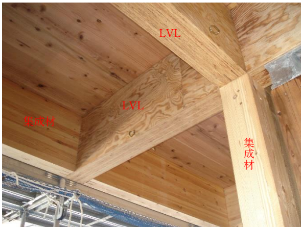
X6-Y5 通り 2階梁：JAS 構造用集成材 1階柱：JAS 構造用集成材
