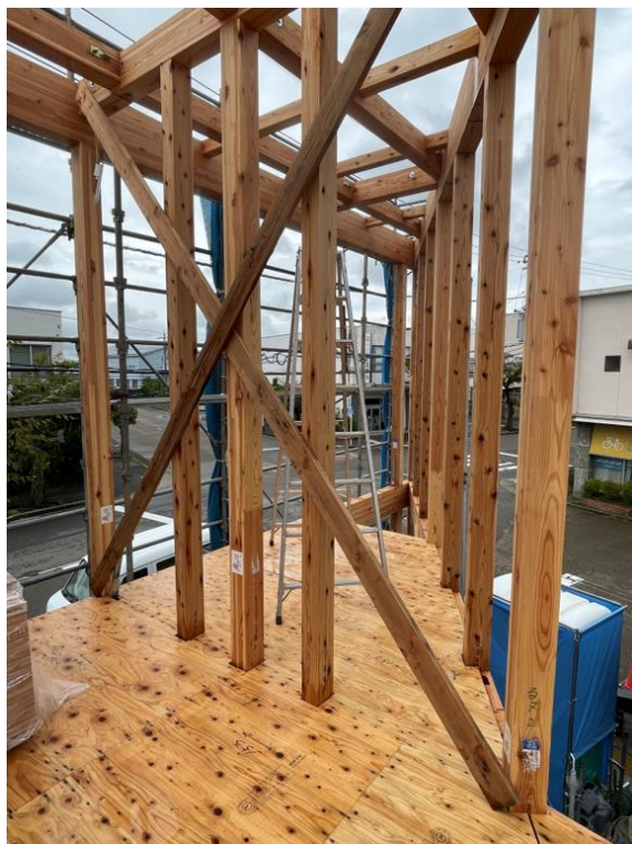
2階 Q11 通り付近柱 唐松 JAS 構造用集成材 E95-F315
