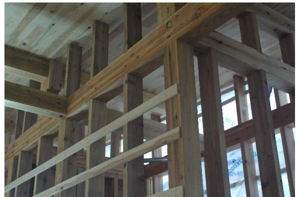
2階内観 給湯室、廊下の壁
