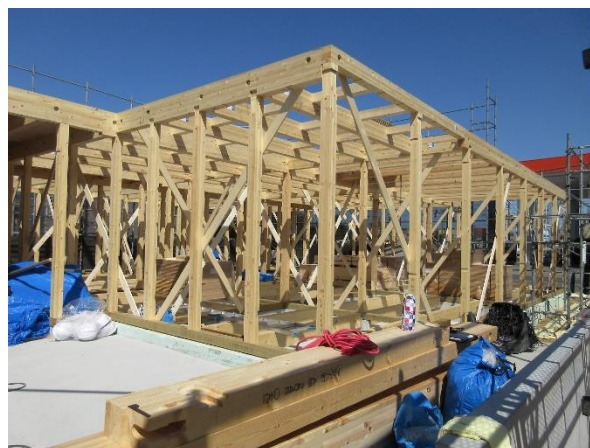
外観 A 棟 1 階 北側 (右半分)
