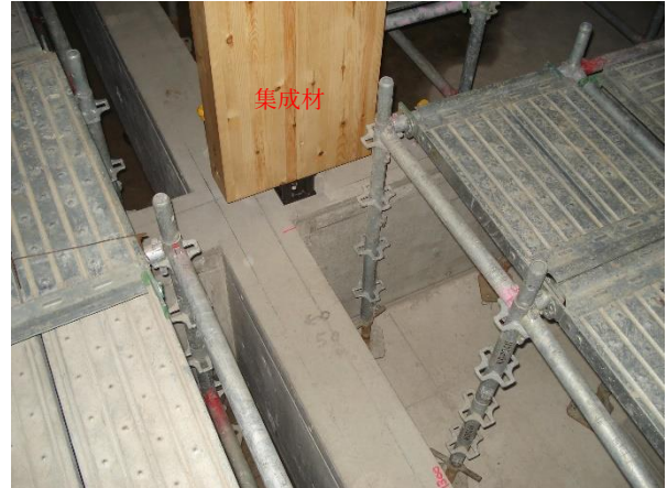
X5-Y2 通り 1 階柱：JAS 構造用集成材 120×450 金物固定
