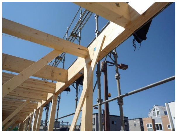
A棟 1通方向梁 JAS 構造用集成材
