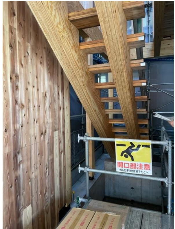
X8-Y5 1階階段ささら桁 : LVL150×450
