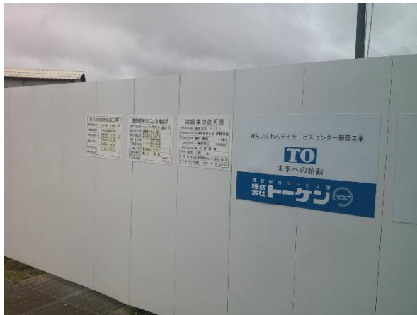
仮囲い：建築確認表示板、建設業許可票、労災保険関係成立票
