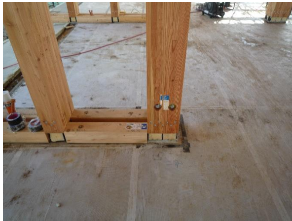
1階 い・11 通柱土台 JAS 構造用集成材
