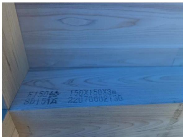
3階 Y7通梁 ベイマツ 構造用集成材 (JASマーク)
