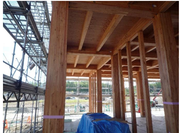
1階 い通り南方向柱・梁 JAS 構造用集成材
