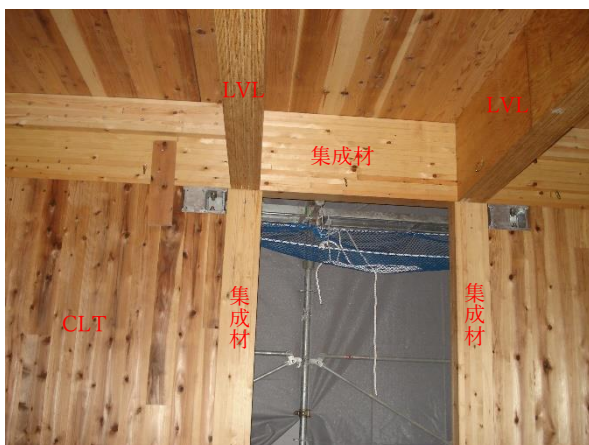
X1-Y3 通り 1 階 柱：JAS 構造用集成材 1 階壁：CLT 2 階梁：JAS 構造用集成材
