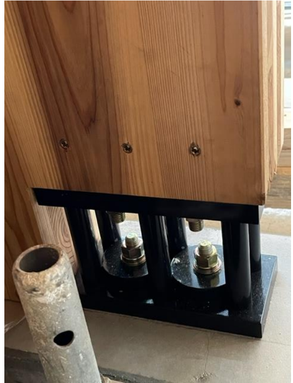
1階 CLT 基礎部分接合金物
