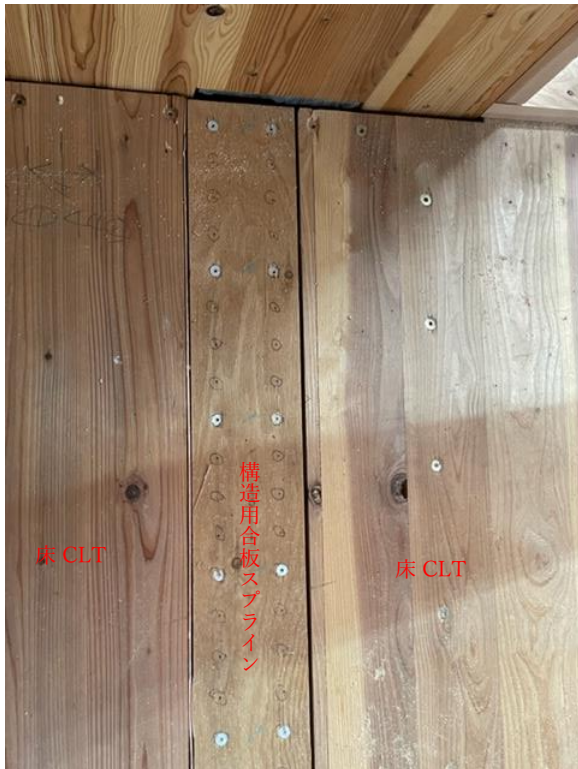
2階床 CLT 版の接合部の構造用合板のスプライン
