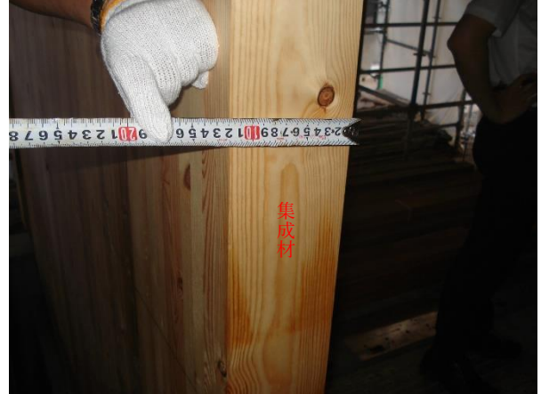
X3-Y4 通り 2階柱：JAS 構造用集成材 120×330
