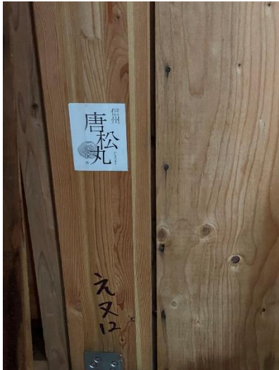
1階食堂 X14-Y7 通り 柱 C5 : JAS 構造用集成材 150×150
