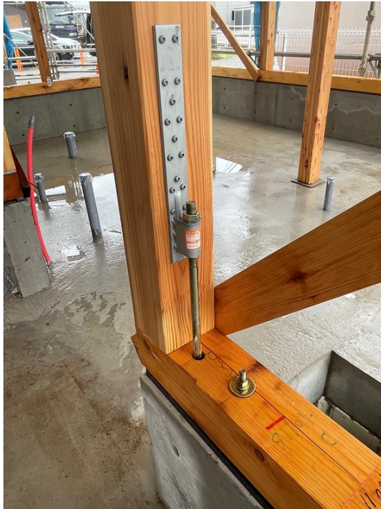
1階 Q3 通り柱脚ホールダウン金物
