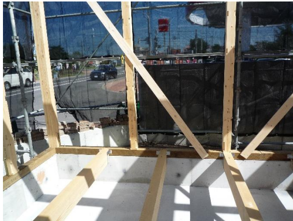
A棟 北西面柱 JAS 構造用集成材
