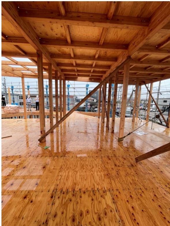
2階 Q3~Q4 通り柱、梁 JAS 構造用集成材
