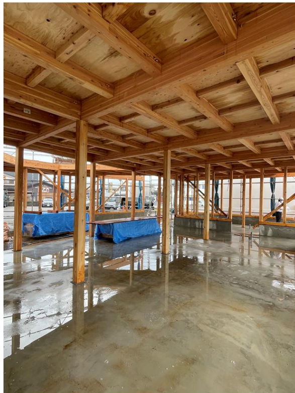
1階 R3-Q4~6 通り柱 (C2A) 3本 能登ヒバ JAS 構造用集成材 E95-F315
