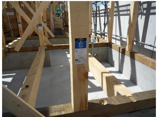
A 棟 柱 JAS 構造用集成材 JAS マーク
