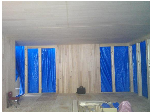
2階 X7通柱 機械等級製材 壁 CLTパネル
