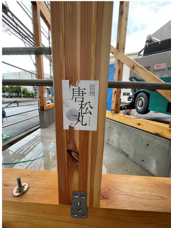
1階 Q11-R4 通り柱 唐松 JAS 構造用集成材 E-95-F315
