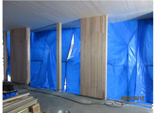
1階 Y7-X2~5 CLT パネル及び柱 機械等級製材
