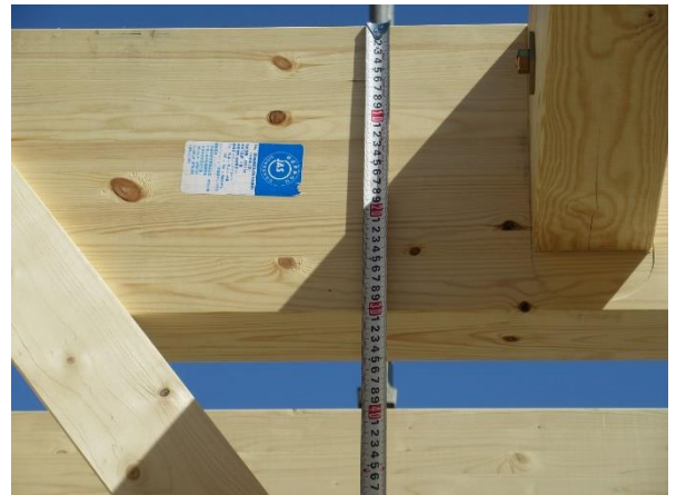
1階 A棟 4通×の~く通 JAS 構造用集成材 105×300 梁 RW
