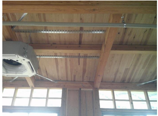
1階機能訓練室 X3-Y10 通り 梁 B2 : JAS 構造用集成材 120×210
