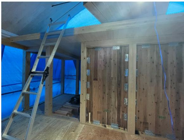
3階 X2通 CLT パネル
