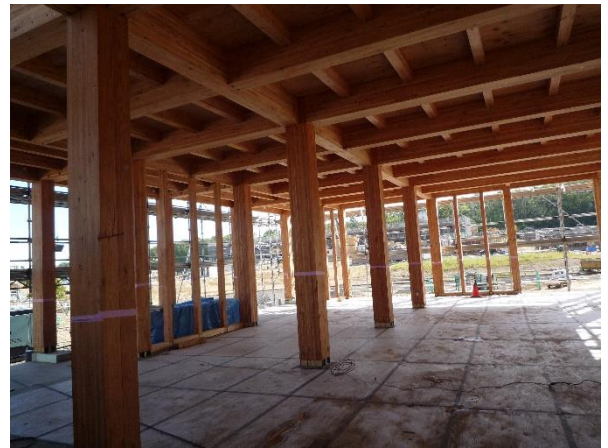
1階 東南面 柱・梁・土台 JAS 構造用集成材
