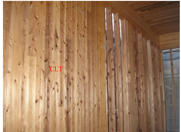
X6 通り 2階壁：CLT 厚 120
