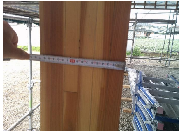
1階車寄せ：柱 C6 JAS 構造用集成材 170×170 寸法測定
