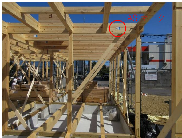
1階 A棟 2~16通×ね~う通 JAS 構造用集成材 柱・梁 RW
