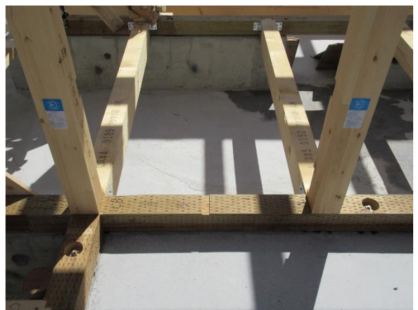
1階 A棟 4~5通×け~ま通 JAS 構造用集成材 105×105 柱 RW
