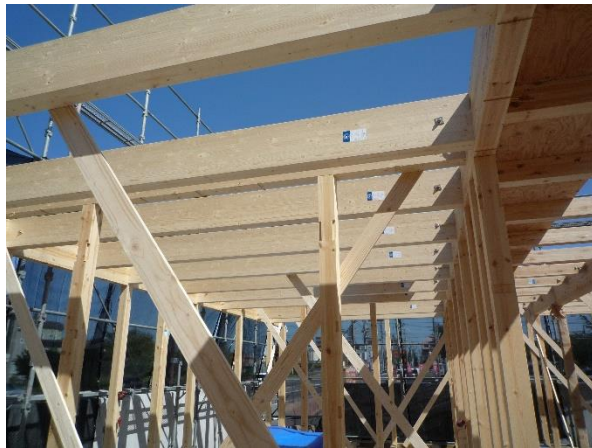
A棟 北西面梁 JAS 構造用集成材
