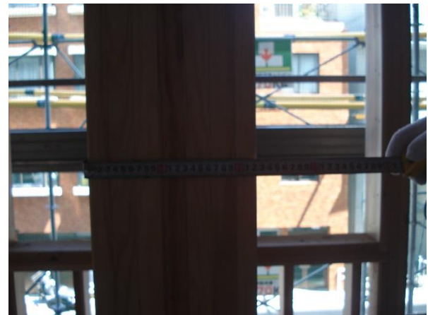
Y5-X5 2 階柱 : JAS 構造用集成材 220×220
