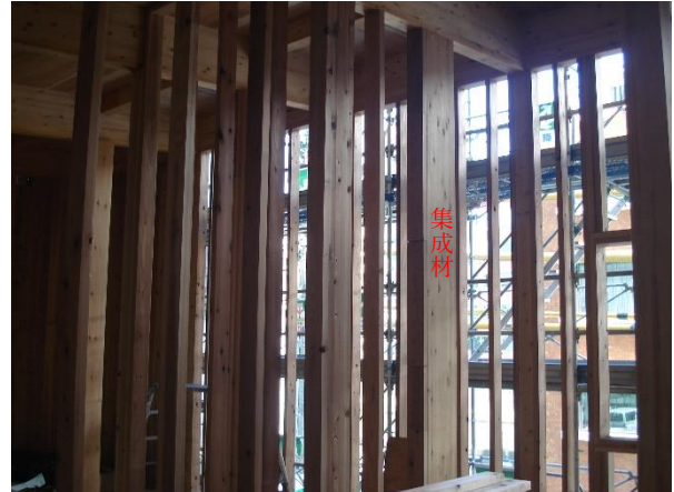
X6-Y1 通り 2 階柱 : JAS 構造用集成材 (内観)
