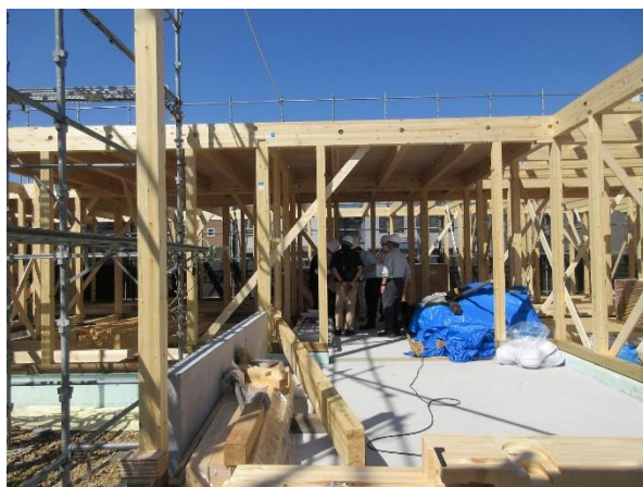
外観 A 棟 1 階 中央 出入口まわり
