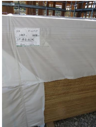
壁面 JAS 構造用合板 荷受け写真
