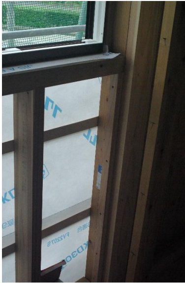
2階事務室 X15 通り 柱 C1:120×120 JAS 構造用集成材 JAS マーク
