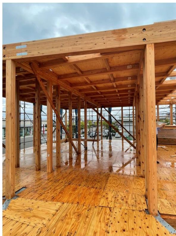
2階 Q3~Q4 通り 柱、梁取り合い JAS 構造用集成材 E105-F300
