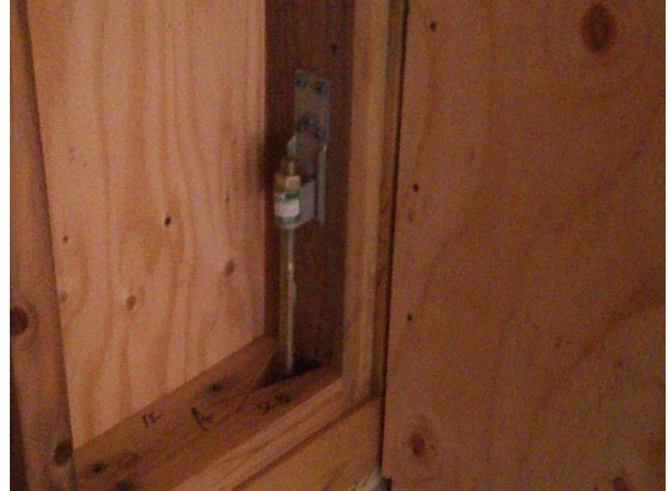
1階風除室 X1-Y3 柱 C1 スギ JAS 構造用集成材 120×120 金物固定
