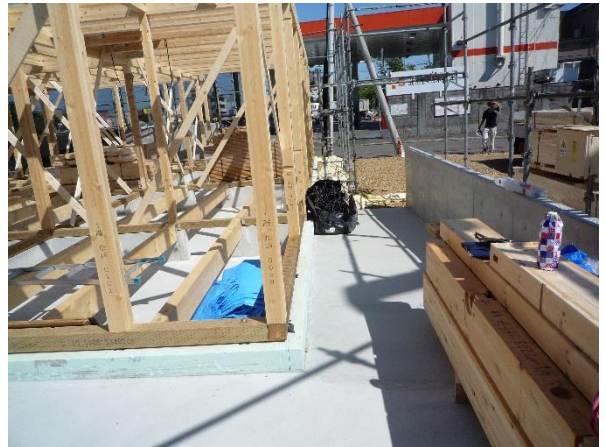
A棟 ね・16通柱 JAS 構造用集成材
