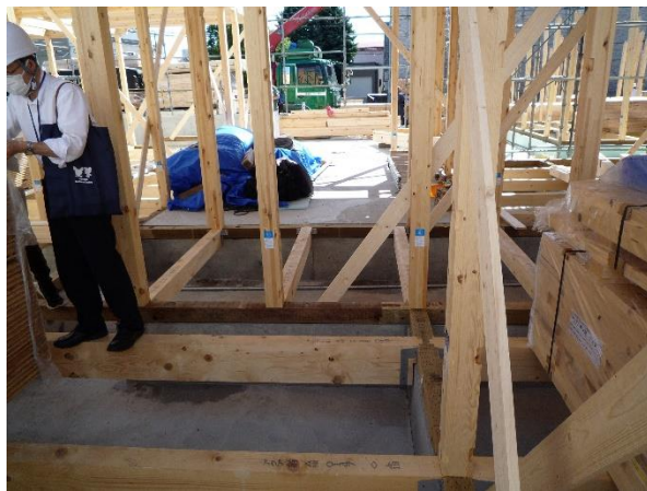
A 棟 19 通より北方向 柱 JAS 構造用集成材
