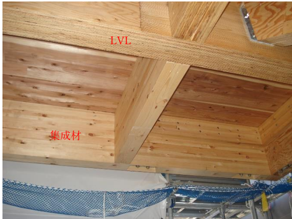
X7 通り 2 階床見上 床梁：LVL・JAS 構造用集成材
