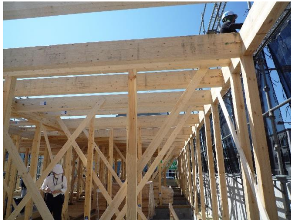
A棟 南西面柱・梁 JAS 構造用集成材
