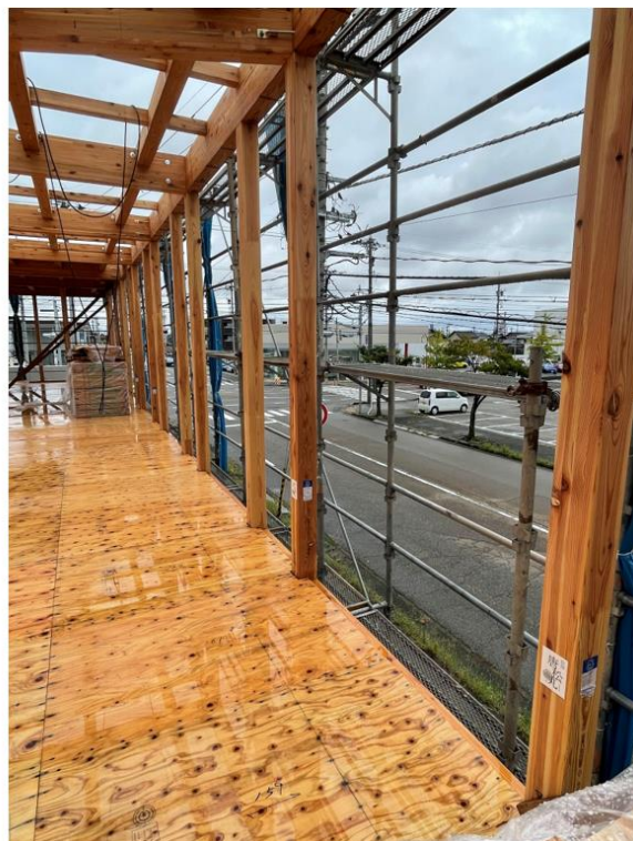
2階 R5 通り付近柱 唐松 JAS 構造用集成材
