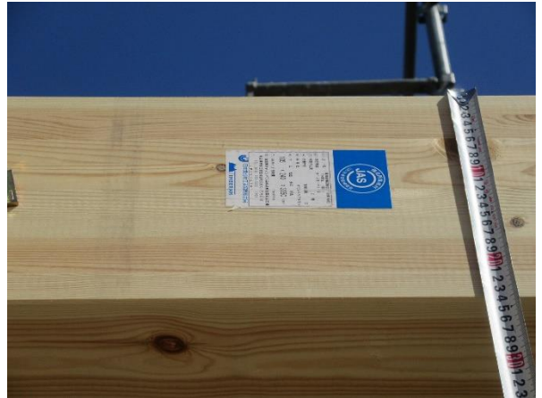
1階 A棟 3通×ら~む通 JAS 構造用集成材 105×240 梁 RW
