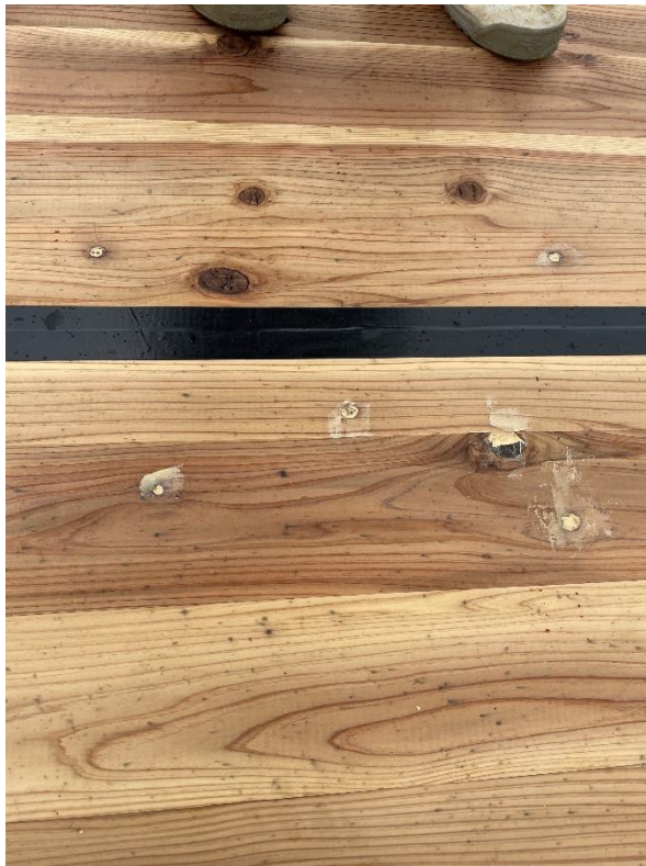
CLT 留めビス、パテ埋め跡
