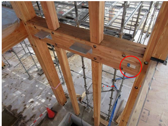
1階 19~22 通×な通 エレベーターシャフト JAS 構造用集成材 合せ梁 カラマツ
