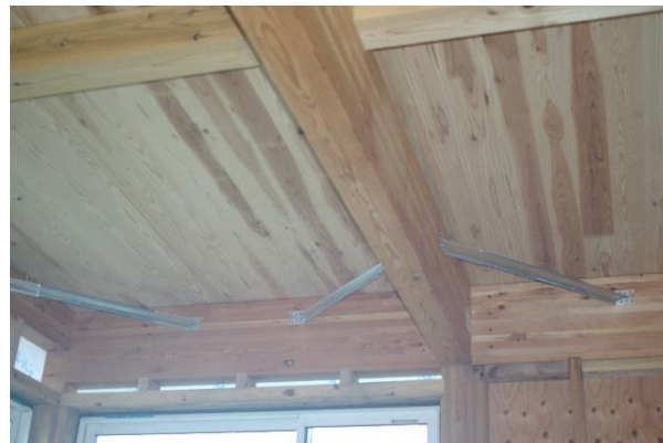
2階社長室 X16 小屋梁 B5:120×330、B12:120×150 JAS 構造用集成材 屋根 CLT 厚 90
