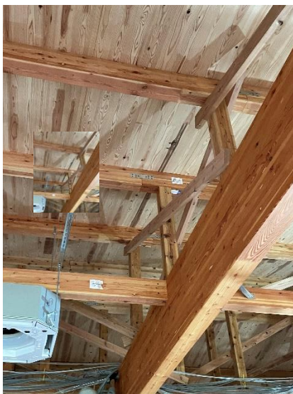
1階食堂 X13 通り 梁 B8 : 150×600、B1:120×180、母屋 : 120×210 JAS 構造用集成材
