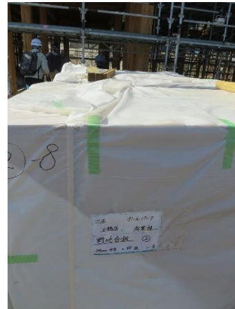
野地板 JAS 構造用合板 荷受け写真
