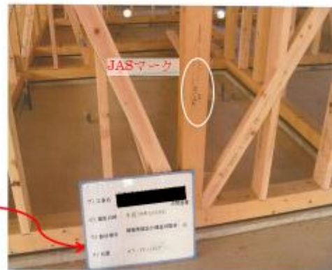
写真 施工写真の例
