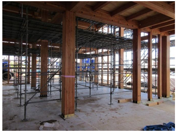
1階 1~11 通×け~も通 JAS 構造用集成材 柱・梁 カラマツ
