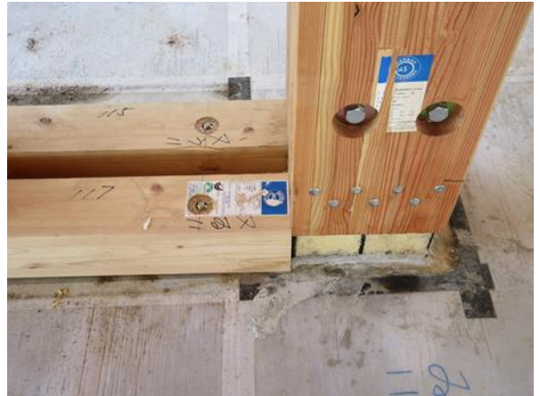
1階 10~11 通×ゐ通 JAS 構造用集成材 120×120 土台 ヒノキ 150×240 合せ柱 カラマツ
