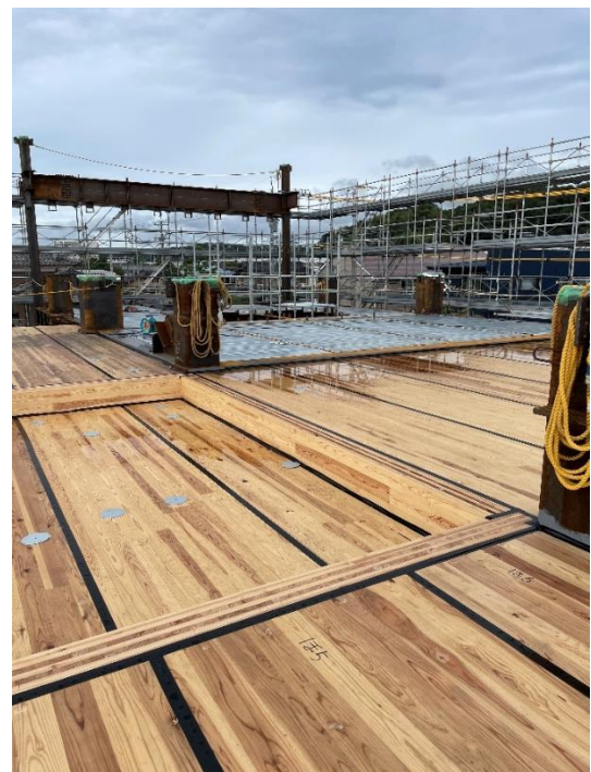
変更部分_段差部分
