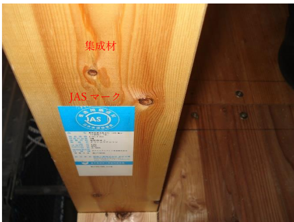
X6-Y5 通り 2階柱：JAS 構造用集成材 JAS マーク
