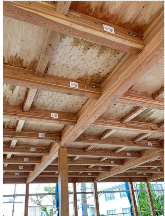
1階 Q4 通り見上げ B33 と B18 取り合い 唐松 JAS 構造用集成材 E105-F300
