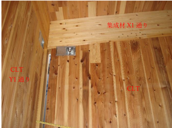
X1-Y1 2階 CLT 壁：R 階梁 JAS 構造用集成材に金物により取付
