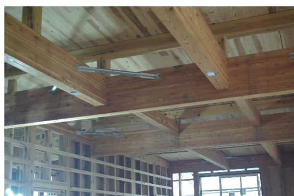
2階社長室 X16 小屋梁 B5:120×330、B12:120×150 JAS 構造用集成材 屋根 CLT 厚 90
