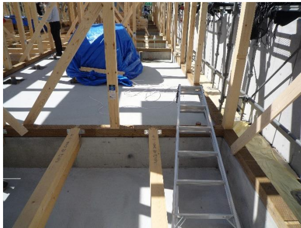
A 棟 て・4 通方向 柱 JAS 構造用集成材
