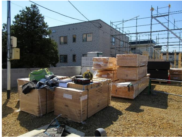
JAS 構造用集成材、構造用合板 荷受け状況
