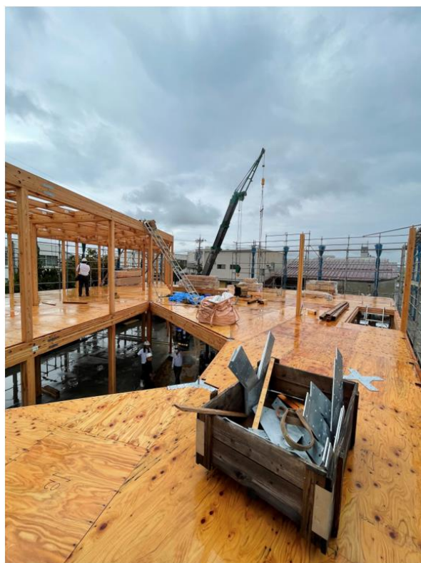
2階 全景 (建方未了)
