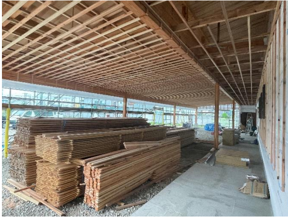
1階エントランス：天井下地 梁：B12-120×150 JAS 構造用集成材
