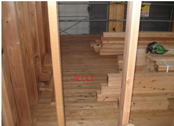
X1-Y1 2階 CLT 壁：R 階梁 JAS 構造用集成材に金物により取付
