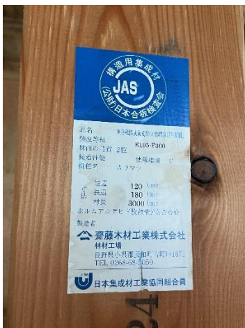
1階脱衣室 X18-Y9 通り 柱 C4：JAS 構造用集成材 120×180 JAS マーク
