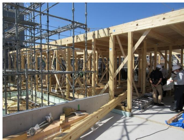
外観 A 棟 1 階 南側 (左半分)
