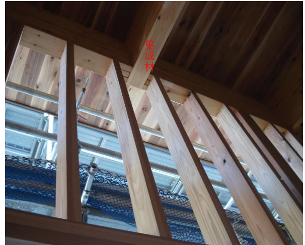
X7-Y6 R 階梁：JAS 構造用集成材
