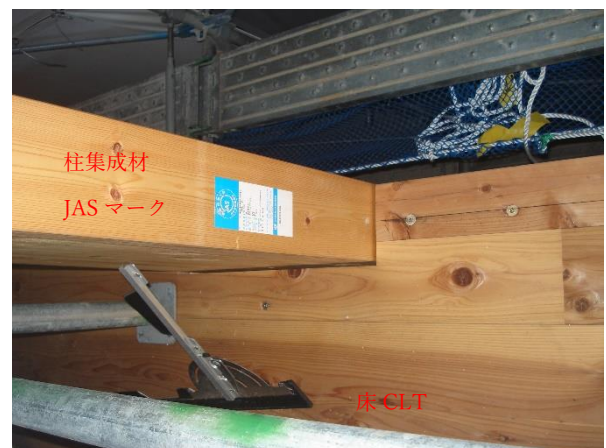
Y1-X2 通り 2 階柱 : JAS 構造用集成材 JAS マーク 2 階床 : CLT
