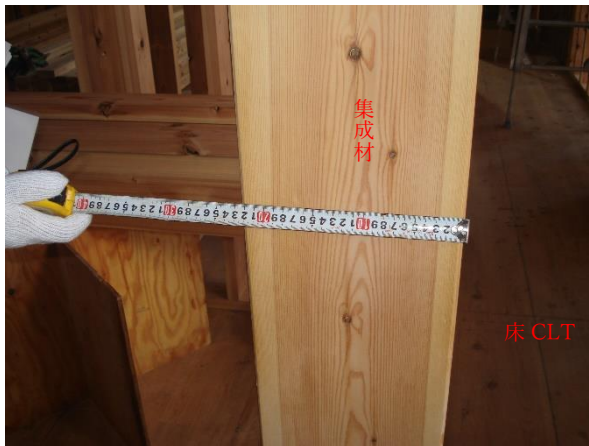
Y5-X5 通り 2 階柱 : JAS 構造用集成材 220×220 2 階床 : CLT
