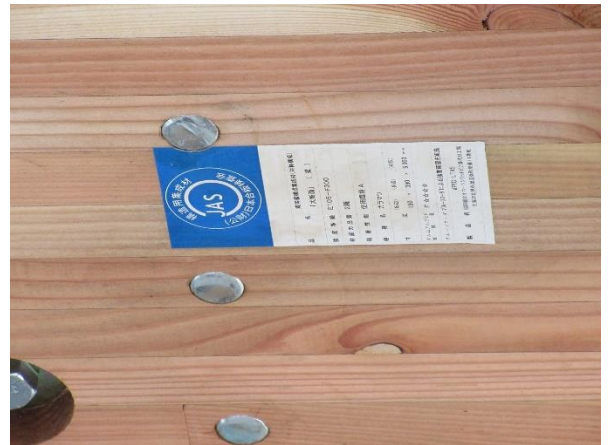
1階 19~22 通×な通 JAS 構造用集成材 150×390 合せ梁 カラマツ
