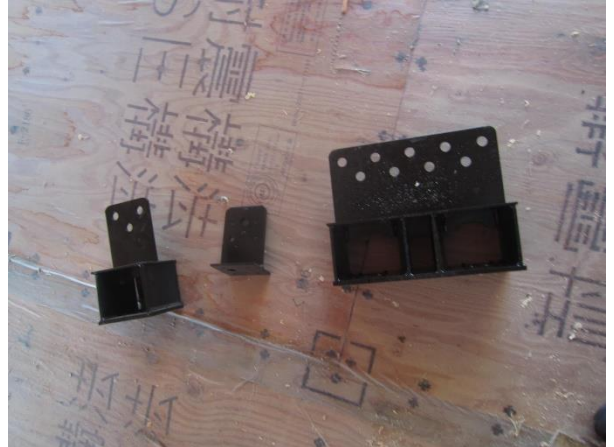
ラーメン工法（商品名：SE 構法）用の接合金物
