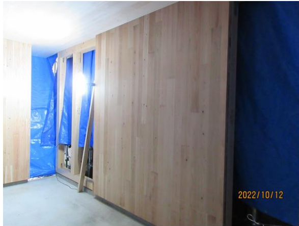
1階 X7-Y3~4 CLT パネル スギ t=90
