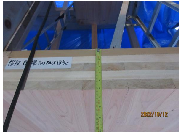
1階 X2 階段踊り場 ヒノキ CLT t=210mm
