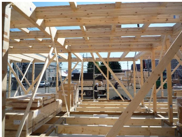
A棟 北東面柱・梁 JAS 構造用集成材
