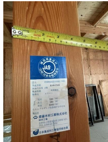
同左 柱 C4：構造用集成材 120×180 寸法測定
