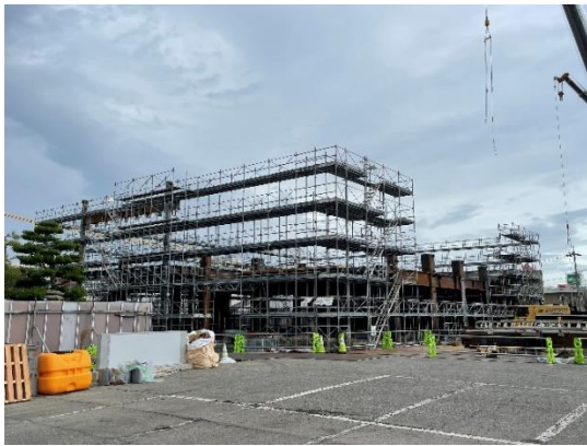
建物西面外観
