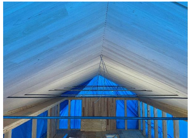
3階 小屋 CLTパネル
