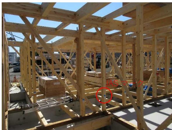
1階 A棟 1~10通×え~ね通 JAS 構造用集成材 柱・梁 RW、WW
