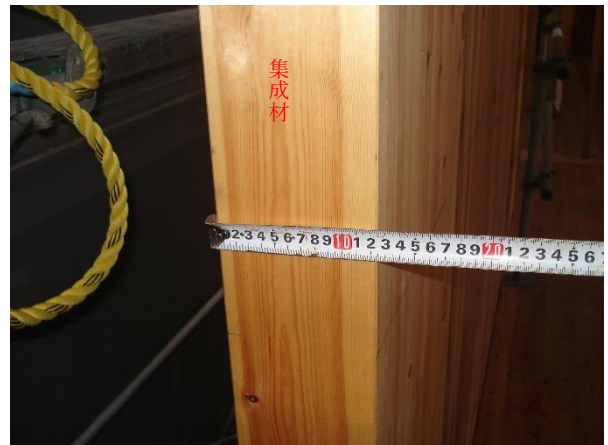
X6-Y5 通り 2階柱：JAS 構造用集成材 120×450
