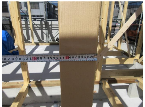
1階 A棟 4通×く~や通 JAS 構造用集成材 120×120 柱 WW
