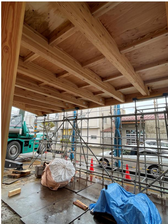
1階 X7 から X8 通り見上げ X8 通りまで 4.55 m の持ち出し (2 階未施工の為単管にて仮受) B33, B30 唐松 JAS 構造用集成材 E105-F300
