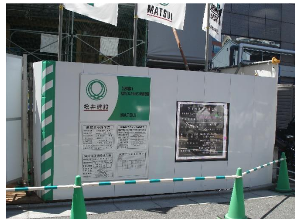
仮囲い：建築確認表示板、防災・建設業許可票、道路占用使用許可証
