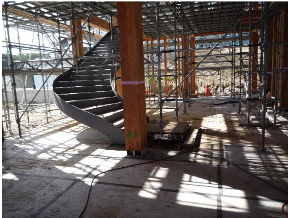
1階 れ通南西面 柱・梁 JAS 構造用集成材
