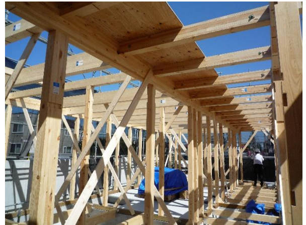
A棟 19通りより北西面柱・梁 JAS 構造用集成材
