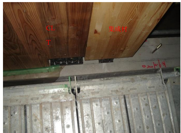
X3-Y5 通り 1 階柱：JAS 構造用集成材、壁：CLT 下部金物固定
