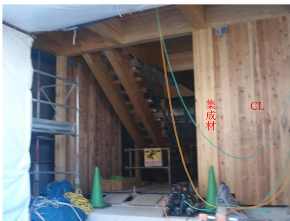
X7 通り正面 1階柱：JAS 構造用集成材 1階壁：CLT
