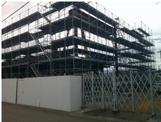
建物東南面外観
