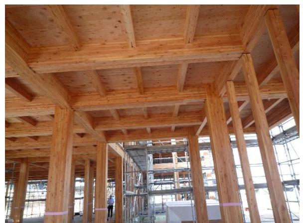
1階 8通り方向 柱・梁 JAS 構造用集成材
