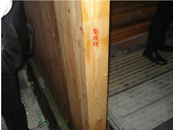
X3-Y4 通り 1階柱：JAS 構造用集成材
