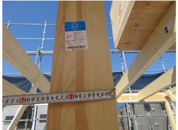
1階 A棟 7通×ま~け通 JAS 構造用集成材 105×150 柱 RW
