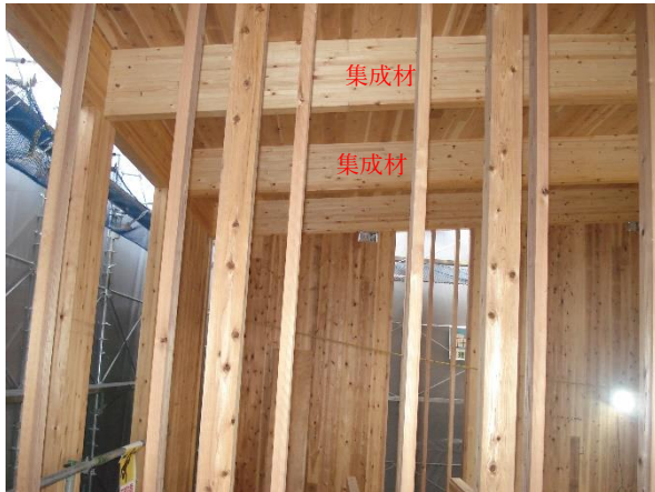
X5,X3,X2 通り R 階梁 : JAS 構造用集成材 (内観)
