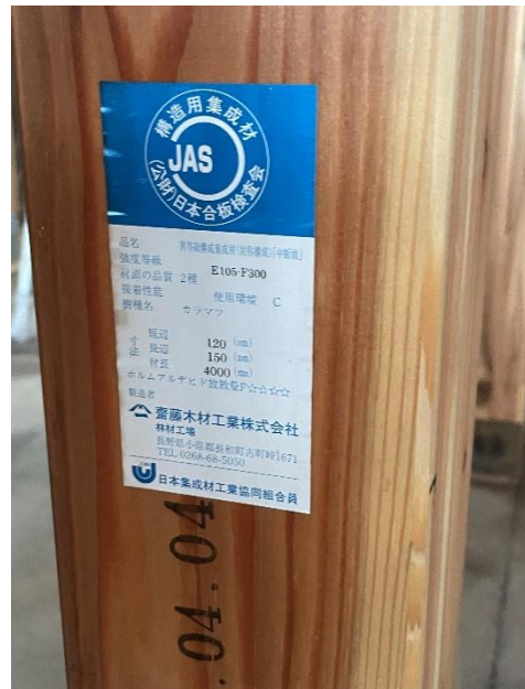
1階脱衣室 X18-Y8 通り 柱 C3：JAS 構造用集成材 120×150 JAS マーク
