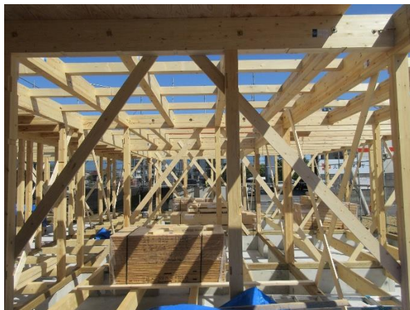
1階 A棟 17~2通×う~く通 JAS 構造用集成材 柱・梁 RW
