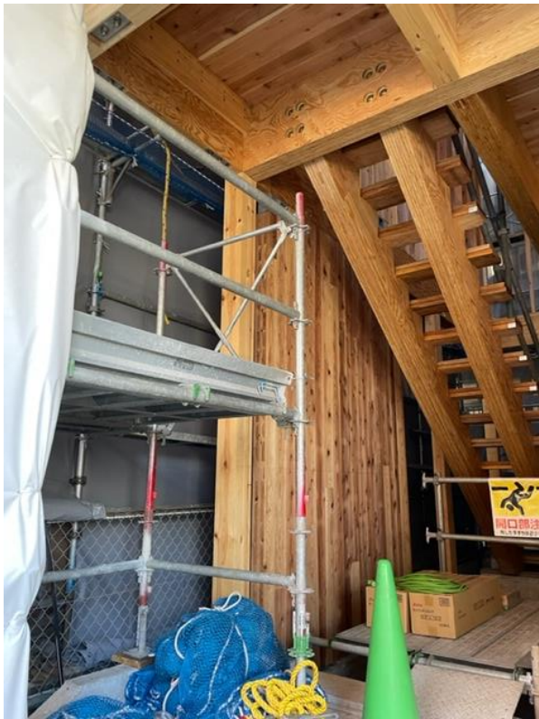
X8-Y5 2階梁ささら桁受け梁 : LVL
