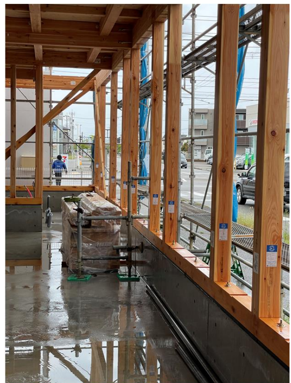
1階 R5 通り柱 唐松 JAS 構造用集成材 E95-F315
