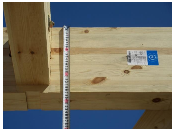
1階 A棟 12通×ね~な通 JAS 構造用集成材 105×270 梁 RW
