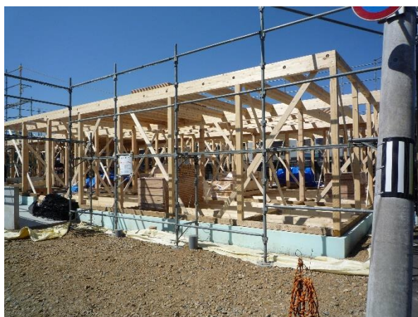
A棟 西面建て方状況
