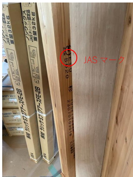
1 階 事務所棟 10 通×る~を通 柱：JAS 機械等級区分構造用製材
