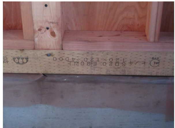
C5 棟 1F X1×Y4~5 通 土台: JAS 機械等級構造用製材 E90 以上 SD20 ヒノキ
