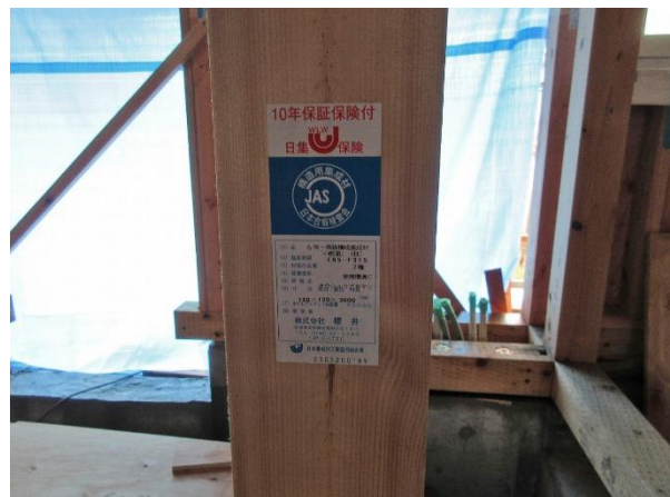
C5 棟 1F X2×Y6 柱：JAS 構造用 集成材 E95-F315 オシユウアカツ
