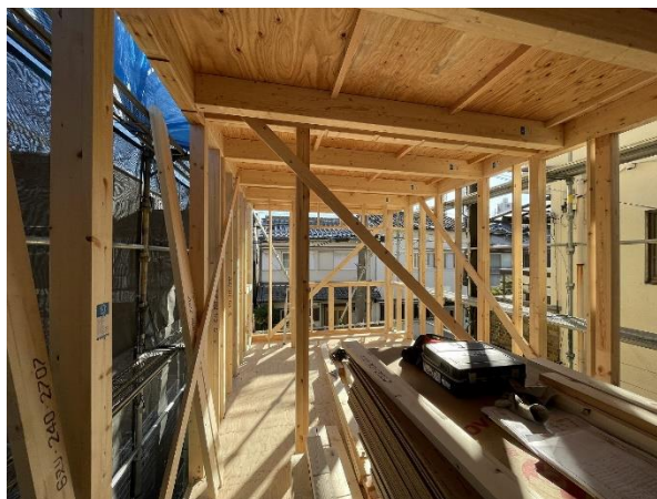
2F 南棟 2 \sim 6 \times ほ \sim よ通 柱：JAS 構造用集成材 E95-F315 RW
