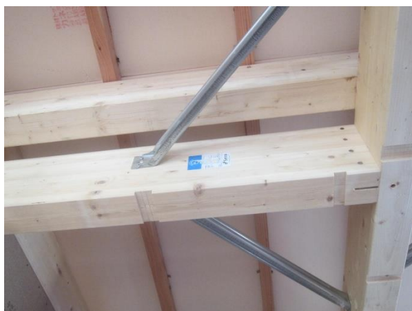
3F 北棟 3×ち〜り通 梁桁：JAS 構造用集成材 E105-F345 RW
