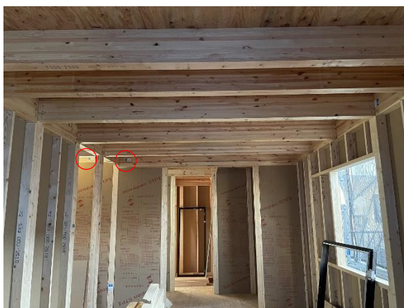
2F 北棟 1~5×に~る通 梁桁：JAS 構造用集成材 E105-F345 RW
