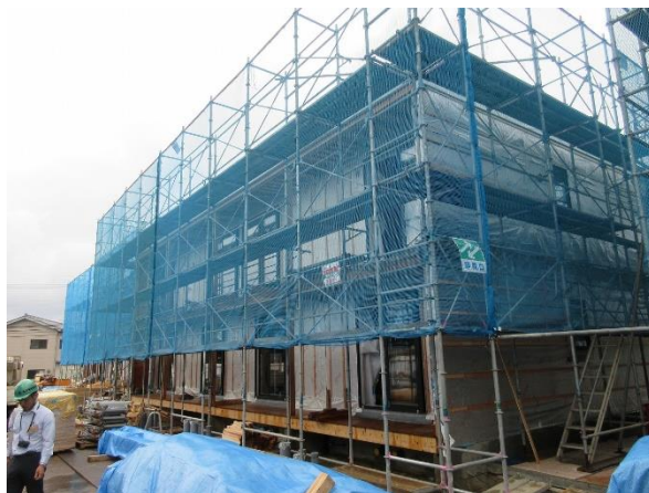
外観（C5 棟 南東面） バルコニー側 立面 表記（共通）○：集成材 JAS シール ○：製材 JAS 印字 確認
