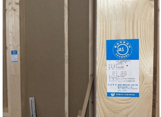
2F 北棟 8~9×と~ち通 柱：JAS 構造用集成材 E95-F315 WW
