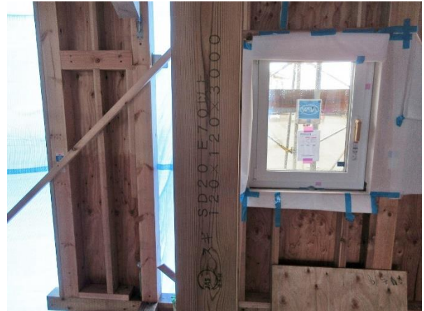
C5 棟 1F X2×Y6~7 通 柱: JAS 機械等級構造用製材 E70 以上 SD20 杉、JAS 印字
