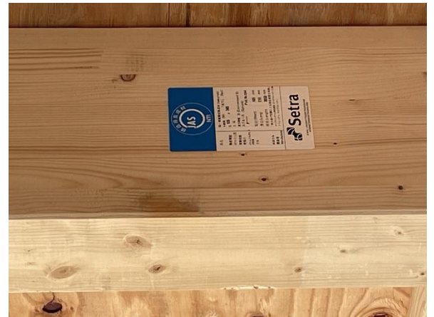
2F 南棟 2~6×ち通 梁桁：JAS 構造用集成材 E105-F345 WW
