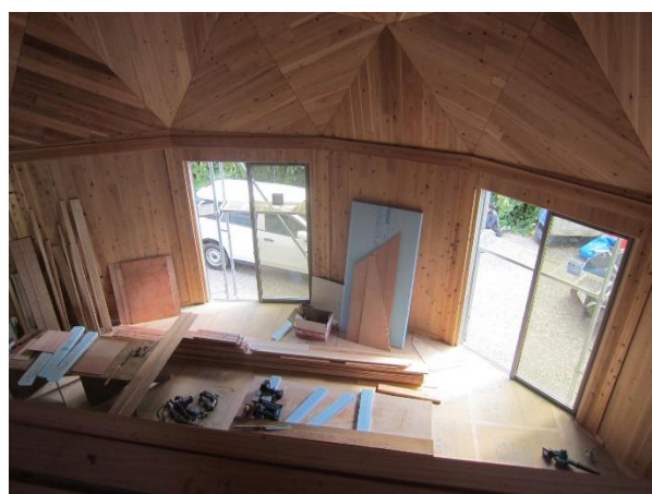
事務所棟内観 2階から1階を見下ろし
