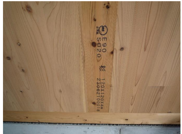
倉庫棟 わ・2 通方向 柱 JAS マーク
