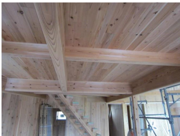
1階事務所棟 7~11 通×ち~わ通 JAS 機械等級区分構造用製材 化粧材のため、 JAS マークは確認できず
