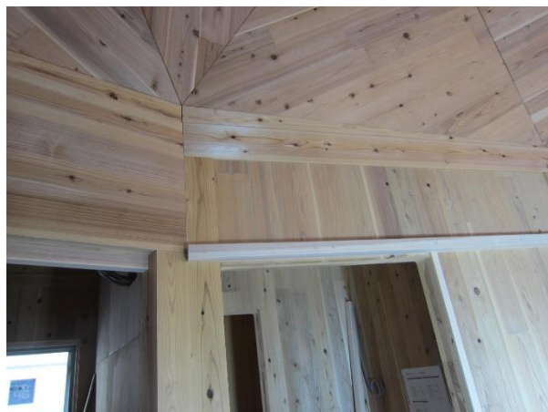
1 階 事務所棟 4~7 通×を~わ通 柱梁：JAS 機械等級区分構造用製材 壁：CLT3 層 3 プライ
