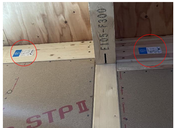
2F 北棟 4~6×ち~り通 梁桁：JAS 構造用集成材 E105-F345 RW/WW
