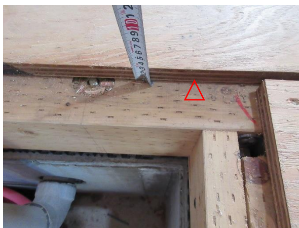
C5 棟 1F X2~3×Y6~7 通 土台: JAS 機械等級構造用製材 床: JAS 構造用合板 t24
