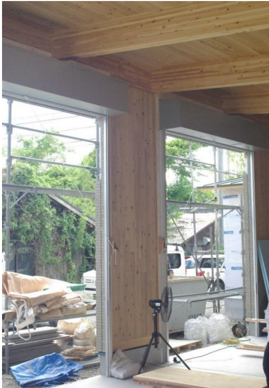
倉庫棟 南面シャッター納まり
