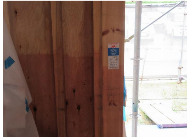
C5 棟 1F X1×Y2~2a 通 柱: JAS 構造用 集成材 E95-F315 オウシュウアカマツ (櫻井)
