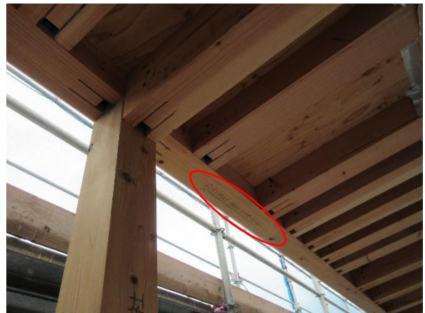
C5 棟 2F X5×Y5a 通 バルコニー柱・ 梁: JAS 機械等級構造用製材 (杉・ベイマツ)
