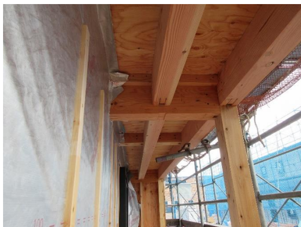
C5 棟 1F X4~5×Y5~7 通 バルコニー柱・ 梁: JAS 機械等級構造用製材 (杉・ベイツ)
