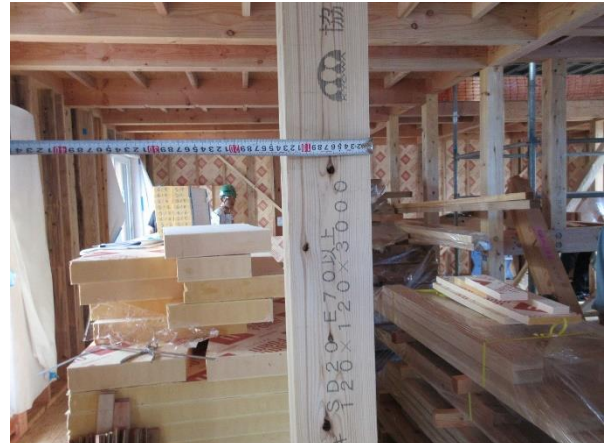
C5 棟 1F X3~4(中間)×Y4 通 柱: JAS 機械等級構造用製材 E70 SD20 杉、JAS 印字
