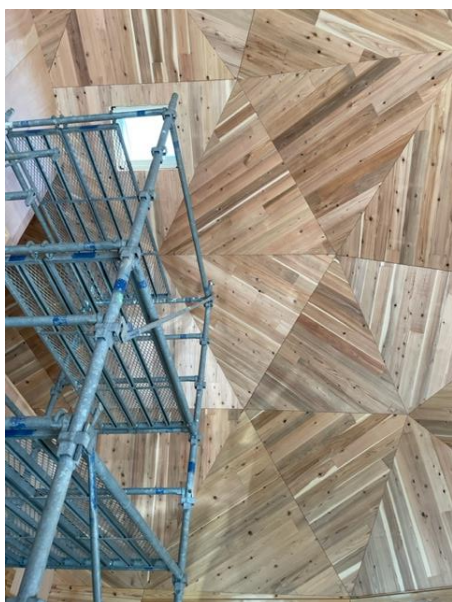
事務所棟 内観 1階から屋根を見上げ
