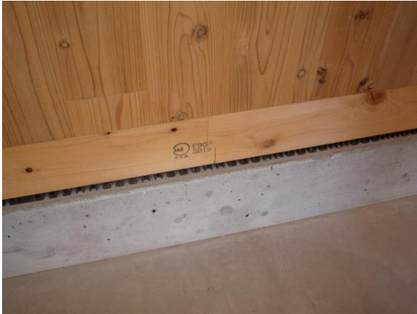
倉庫棟 と・7 通方向 土台 JAS 機械等級製材
