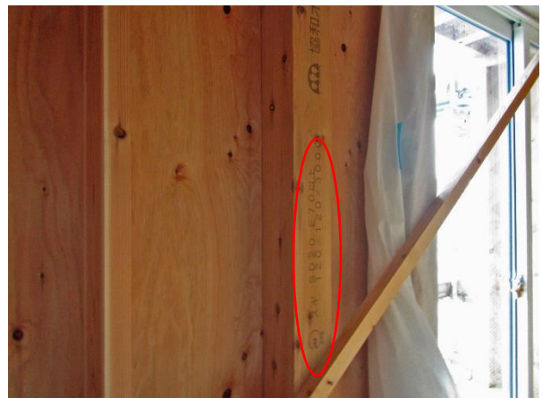
C5 棟 2F X4×Y2 通 柱: JAS 機械等級 構造用製材 E70 以上 SD20 杉
