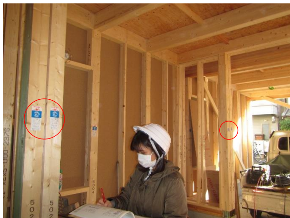
1F 南棟 4~6×ち~よ通 柱：JAS 構造用集成材 E95-F315 WW
