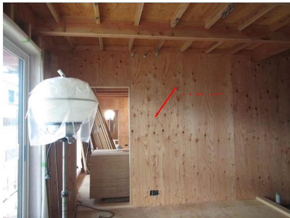
C1 棟 1F X3~4×Y4 通 戸境壁: JAS 構造用合板 t9
