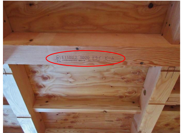
C5 棟 1F X2×Y6~7 通 梁: JAS 機械等級構造用製材 E110 SD20 ベイマツ JAS 印字
