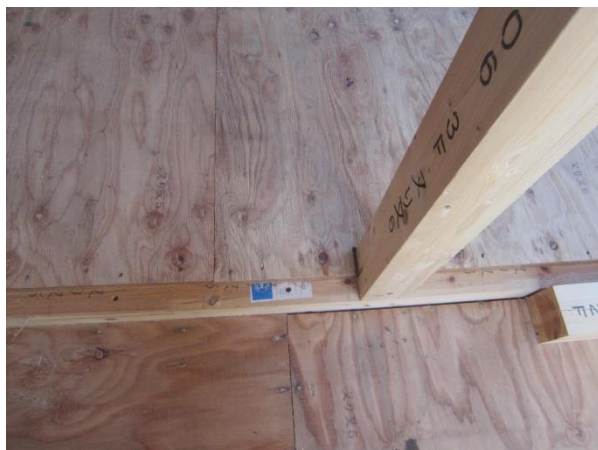
3F 北棟 6×り通 梁桁：JAS 構造用集成材 E105-F345 RW
