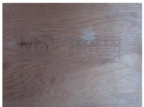
C5 棟 1F X2~3×Y6~7 通 床: JAS 構造用合板 国産カラマツ+富山県産杉 46%以上 林ベニヤ産業 七尾工場
