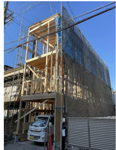
外観前面道路 東側より ▽：寸法計測 確認
