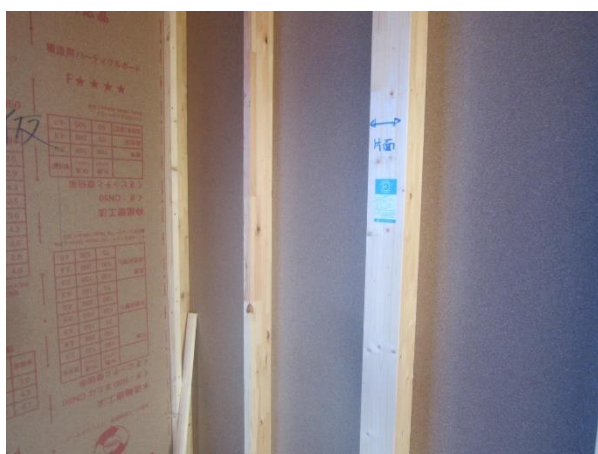
3F 北棟 9×は通 梁桁：JAS 構造用集成材 E95-F315 WW
