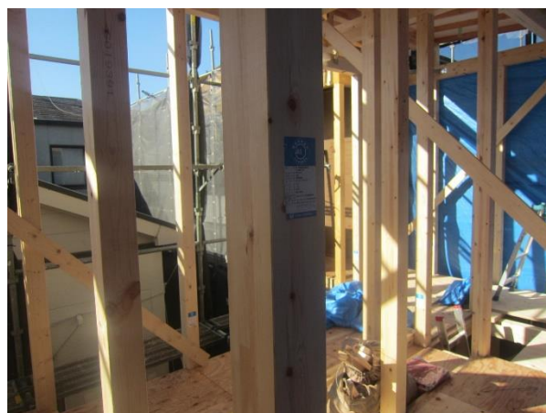
3F 南棟 5×へ ~ 通 柱：JAS 構造用集成材 E95-F315 RW
