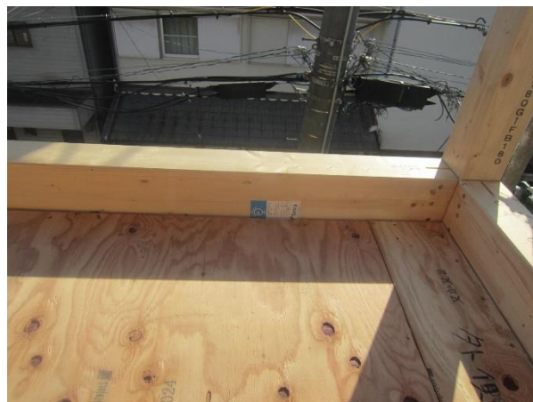
3F 南棟 2~3×よ通 梁桁：JAS 構造用集成材 E105-F345 WW
