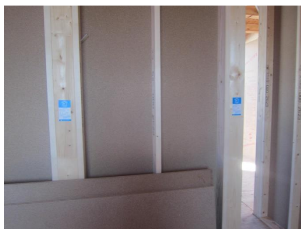
3F 北棟 5×へ〜と通 梁桁：JAS 構造用集成材 E95-F315 WW
