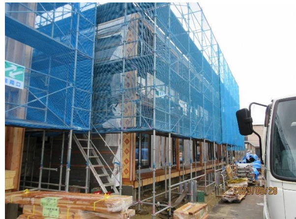
外観（C5 棟 南西面） バルコニー側 立面 ▽：寸法計測 確認
