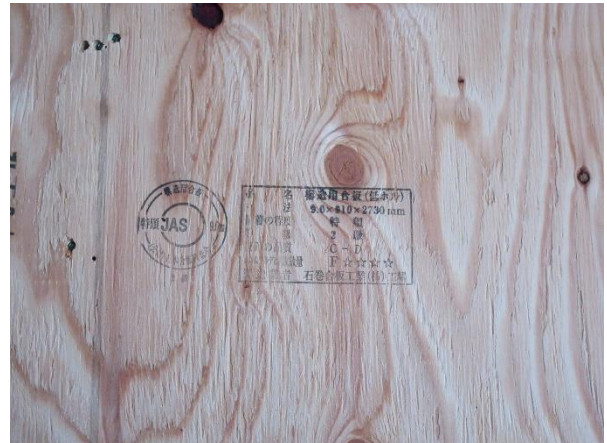
C1 棟 1F X3~4×Y4 通 戸境壁: JAS 構造用合板 JAS マーク 石巻合板工業
