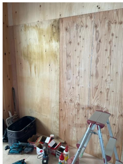
1 階 事務所棟 6~10 通×よ通 構造用合板
