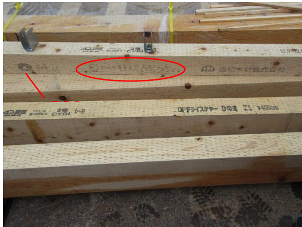
C2 棟 1F 土台: JAS 機械等級構造用製材 E90 SD20 ヒノキ JAS、FIPC マーク 協和木材 (注: ザイエンス)
