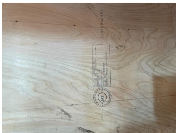
1 階 事務所棟 8~10 通×よ通 構造用合板
