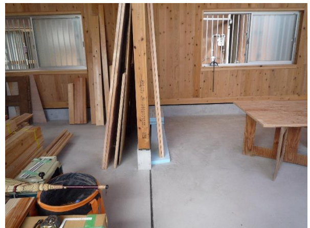
倉庫棟 ほ～わ・7 通方向 壁 JAS CLT3 層 4P 柱 JAS 機械等級製材
