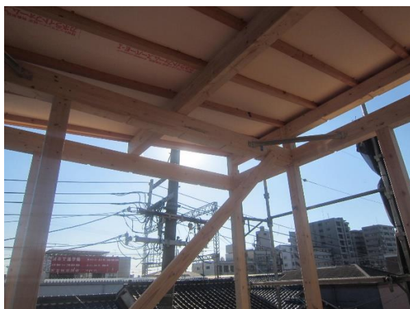
3F 南棟 2~4×か通 梁桁：JAS 構造用集成材 E105-F345 WW
