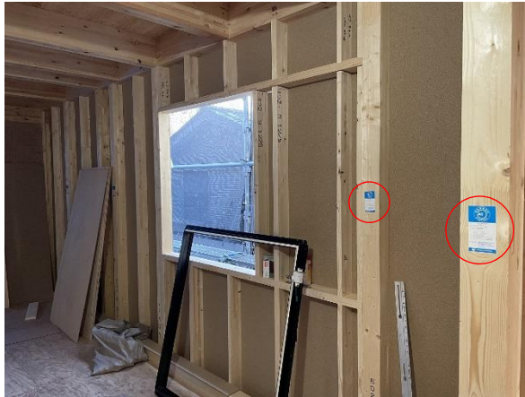
2F 北棟 8~9×ろ~ち通 柱：JAS 構造用集成材 E95-F315 WW
