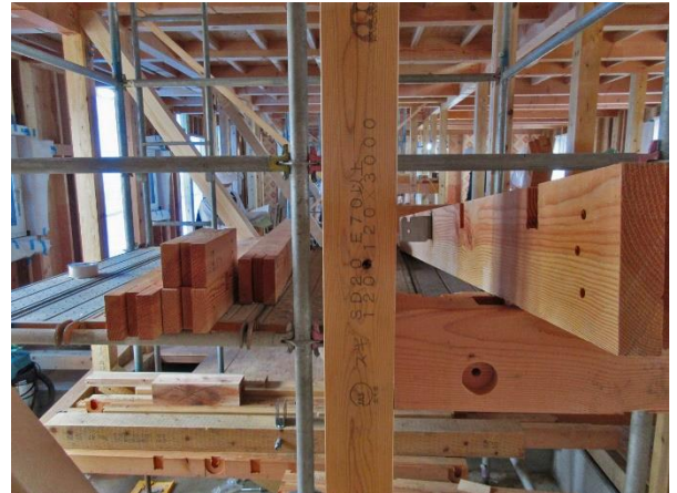
C5 棟 1F X2~3(中間)×Y2 通 柱: JAS 機械等 級構造用製材 E70 以上 SD20 杉 (協和木材) JAS 印字
