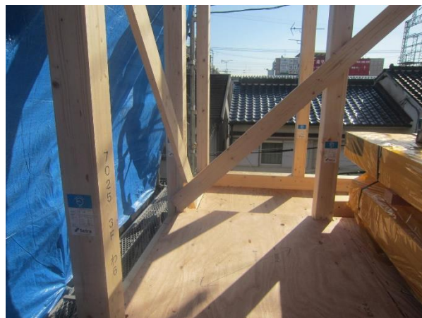
3F 南棟 2 ~ 6× ~ わ ~ よ通 柱：JAS 構造用集成材 E105-F345 WW
