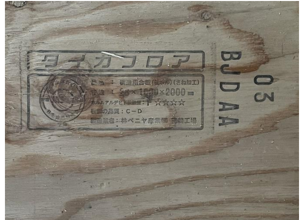
2F 北棟 1 \sim 5 \times い \sim ち通 床：JAS 構造用合板 t28
