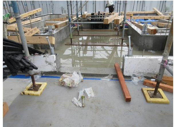
C2 棟 1F 土台・柱脚: 金物工法 接合金物の設置状況
