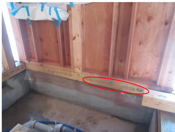
C5 棟 1F X1×Y4~5 通 土台: JAS 機械等級構造用製材 E90 SD20 ヒノキ FIPC マーク
