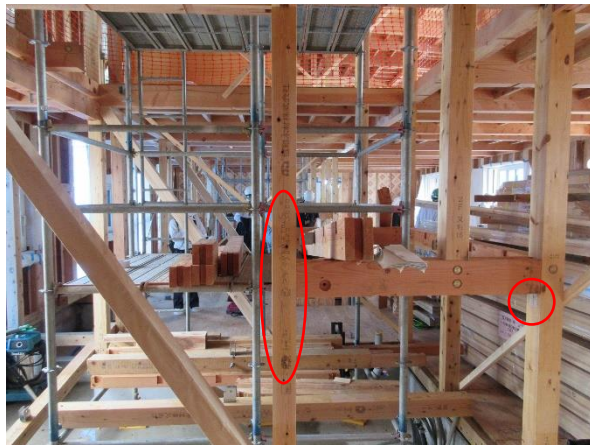
C5 棟 1F X2~3×Y2~4 通 柱: JAS 機械 等級構造用製材、JAS 構造用集成材
