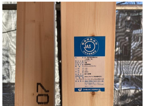
2F 南棟 6 \times ほ通 柱：JAS 構造用集成材 E95-F315 RW
