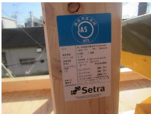
3F 南棟 5×か通 柱：JAS 構造用集成材 E105-F345 WW
