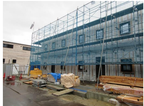
外観（C1 棟 北面） 玄関側 立面
