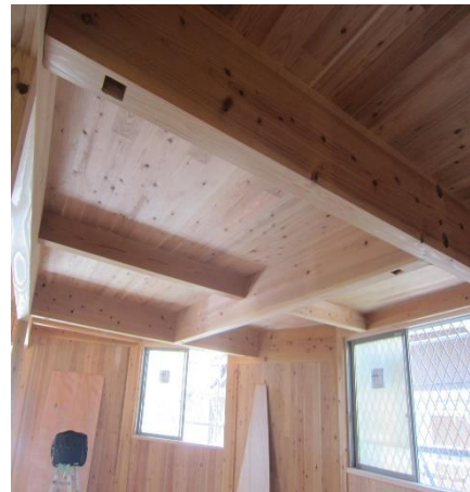
1階事務所棟 7~11 通×は~ち通 JAS 機械等級区分構造用製材 化粧材のため、 JAS マークは確認できず
