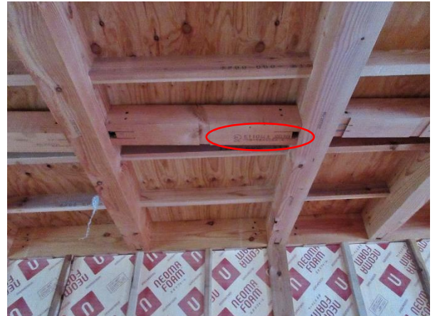
C5 棟 2F X3~4×Y1~2 通 合板受材:: JAS 機械等級構造用製材 E110 以上 SD20 ベイマツ
