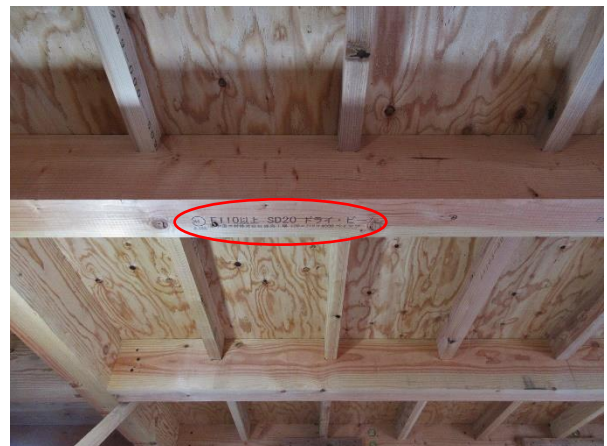
C5 棟 1F X3~4×Y6~7 通 梁: JAS 機械等級構造用製材 E110 SD20 ベイマツ (中国木材ドライビーム) JAS 印字
