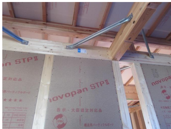
3F 北棟 5×へ〜ち通 梁桁：JAS 構造用集成材 E105-F345 RW
