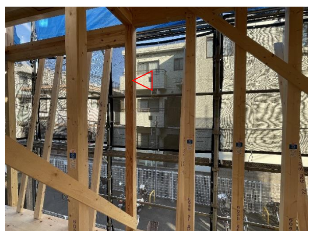
2F 南棟 4 \sim 6 \times い \sim ほ通 通柱：JAS 構造用集成材 E135-F405 米松
