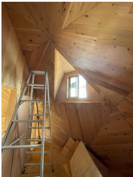
2階 事務所棟 7～10通×は～へ通 CLT3層3プライ屋根
