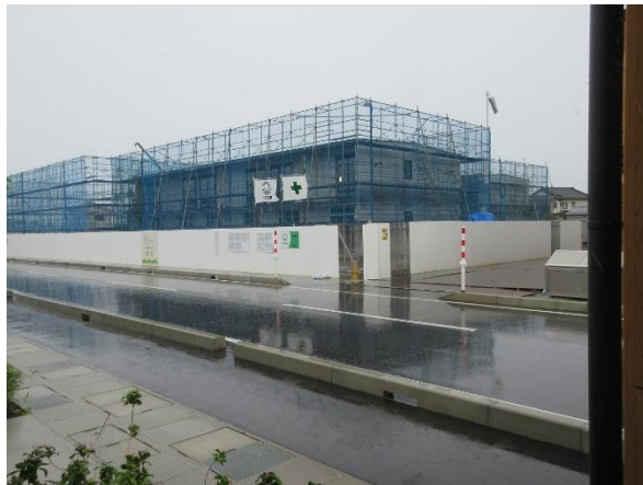
外観 区域全体 手前 C1 棟（南東面）工事柵に表示板
