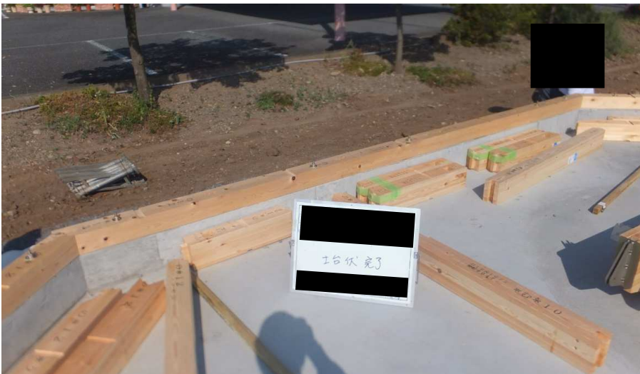
ア) 全木連事務所新築工事 イ) 令和3年4月16日 ウ) 土台敷 エ) 土台部材 JAS目視等級製材
