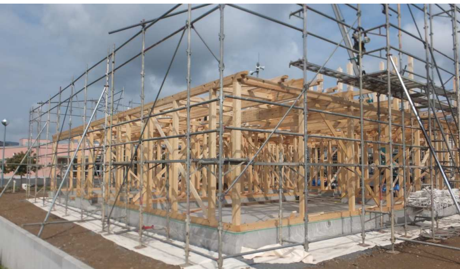
ア) 全木連事務所新築工事 イ) 令和3年4月20日 ウ) 建て方 エ) 1階柱 JAS構造用集成材 1F横架材 JAS目視等級製材 JAS構造用集成材
