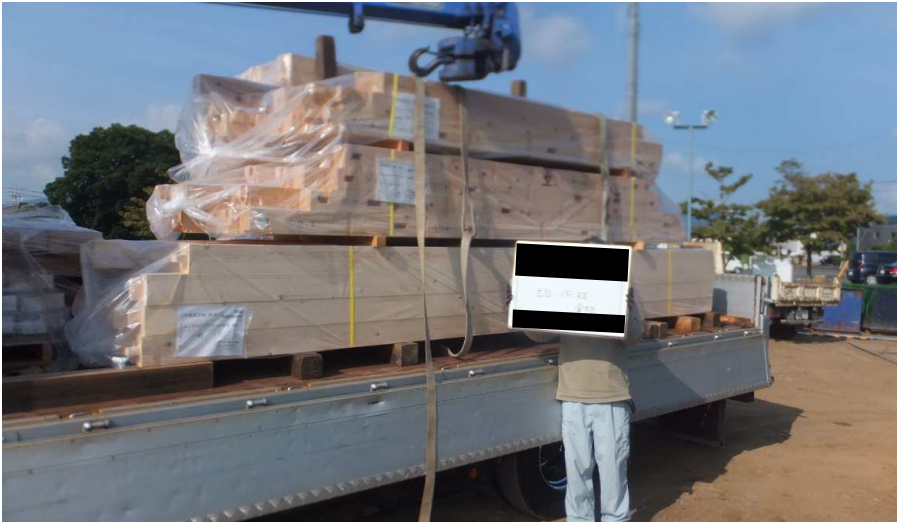
ア) 全木連事務所新築工事 イ) 令和3年4月15日 ウ) 荷受け検収 エ) 土台・1階柱部材 JAS目視等級製材
