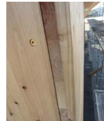
写真 9 CLT 壁相互のビス接合の例
