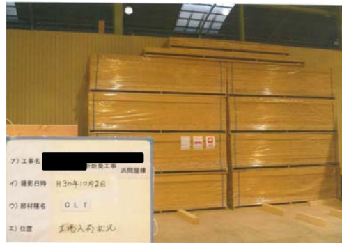
写真 4 材料検収写真(CLT の例)
