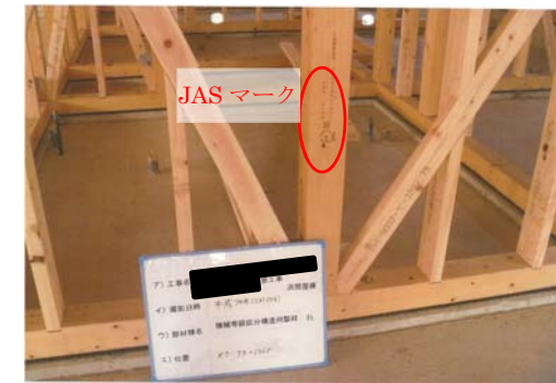
写真 6 施工後の写真(トラス材の例)
