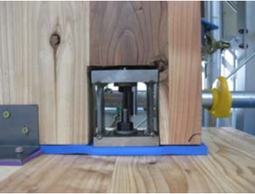
写真1 接合金物のための欠き込み →プレカットなら算入
