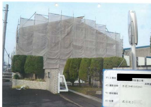
写真 7 建て方終了後の全景写真の例
