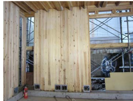
写真 5 施工後の写真(CLT 耐力壁)
