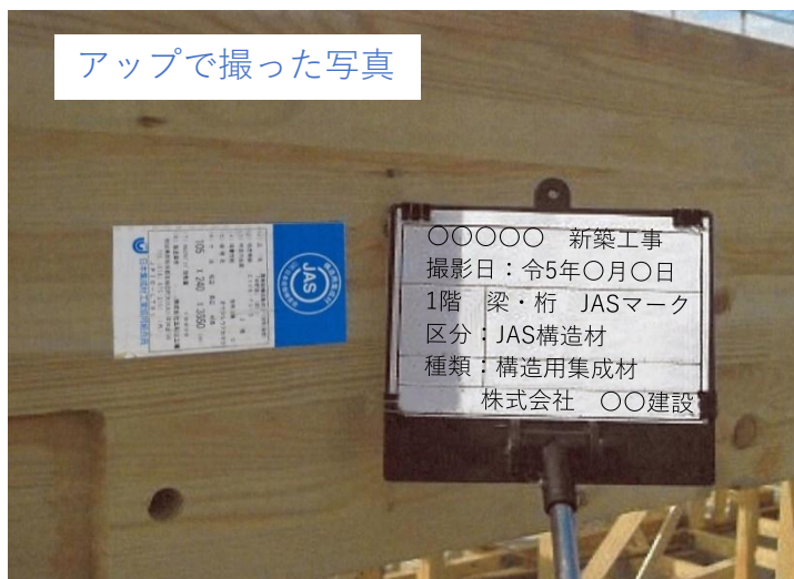
写真 施工写真の例
