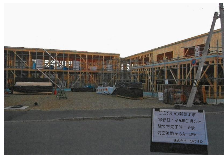
写真 外観写真の例
