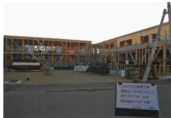
写真 外観写真の例
