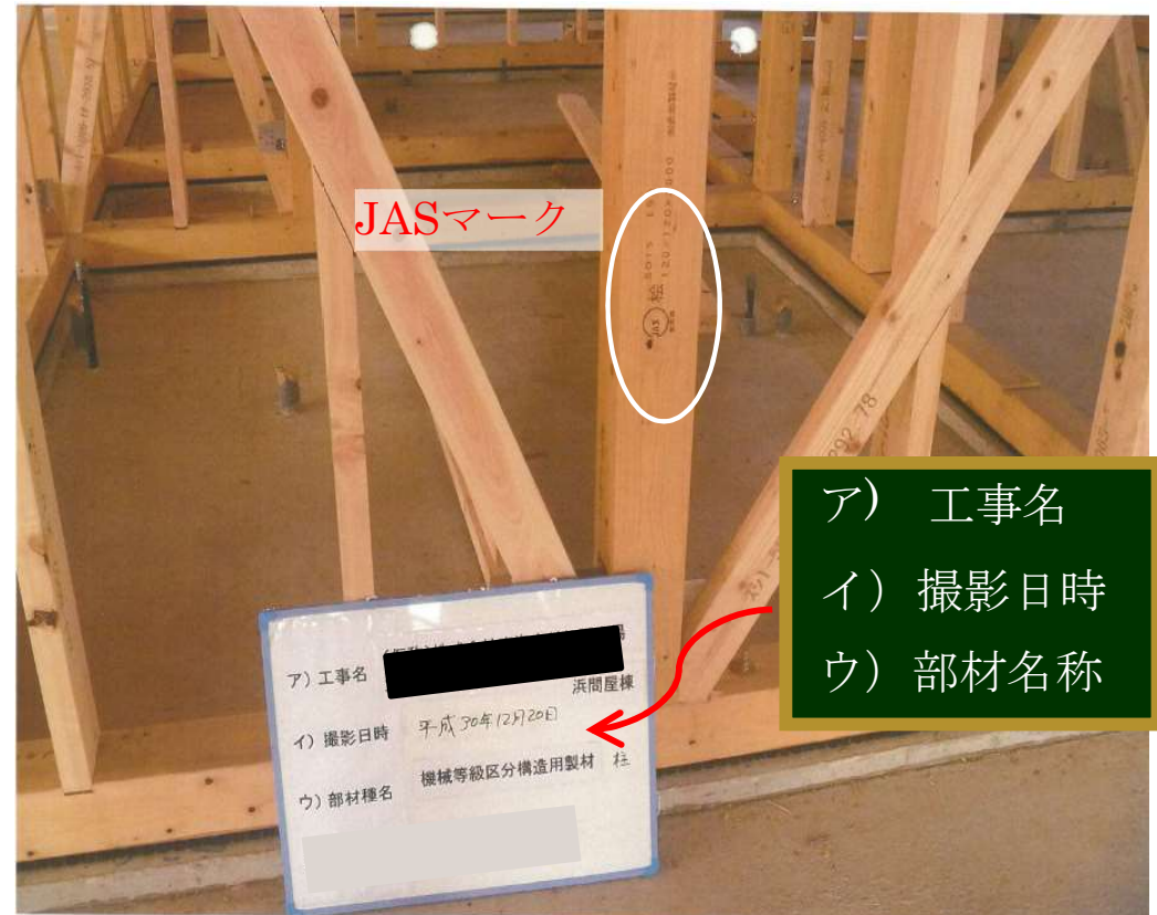
写真 施工写真の例
