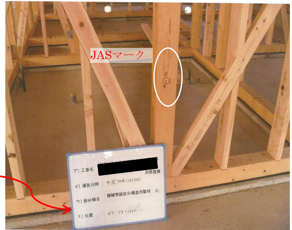
写真 施工写真の例
