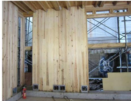
写真5 施工後の写真(CLT耐力壁)
