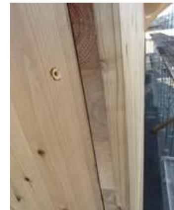
写真9 CLT壁相互のビス接合の例
