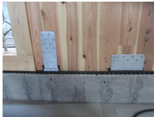
写真8 CLT耐力壁下部の引張金物とせん断金物の例
