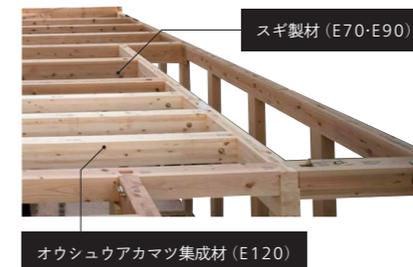
3階床梁(2階天井)を取り付けた後の様子。現しとする部分にはスギ製材(JAS製材)を使用し、被覆する部分には、オウシュウアカマツ集成材(JAS集成材)、ダフリカカラムツLVL(JAS単板積層材)を使用している(写真外)。オウシュウアカマツ集成材(E120)は、スギよりもヤング係数が高いため、梁成を抑えられる。断面寸法を105×180mmとしている
