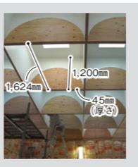
中央に向かって、4本の梁を架け合わせる手法(マグカップと箸でも表現可能)。昔の寺社仏閣でも採用されていた構造形式で、4本の梁が中央部で矩形に重なり合うことで「総持ち」の状態をつくる。長尺材(6m)が入手できない場合や、現場に搬入できない場合に有効な手段。写真の事例では強度の高いLVL(45×1,200mm)による持ち合い構造によって、彫りの深い天井を実現した
