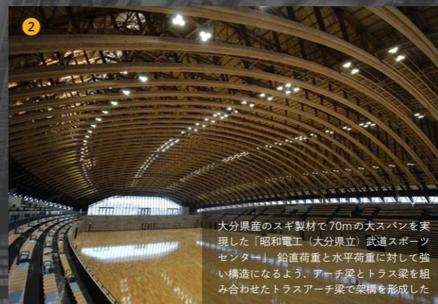
大分県産のスギ製材で70mの大スパンを実現した「昭和電工 (大分県立) 武道スポーツセンター」。鉛直荷重と水平荷重に対して強い構造になるよう、アーチ梁とトラス梁を組み合わせたトラスアーチ梁で架構を形成した
