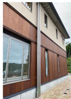
地元産の杉板を縦張り仕上げとした「京丹波町役場」（設計：香山壽夫建築研究所／施工：大成建設）。45分準耐火建築物の外壁なので、JBNが取得した国土交通大臣認定の仕様を採用している。断熱材はグラスウールを使用（充填断熱）
