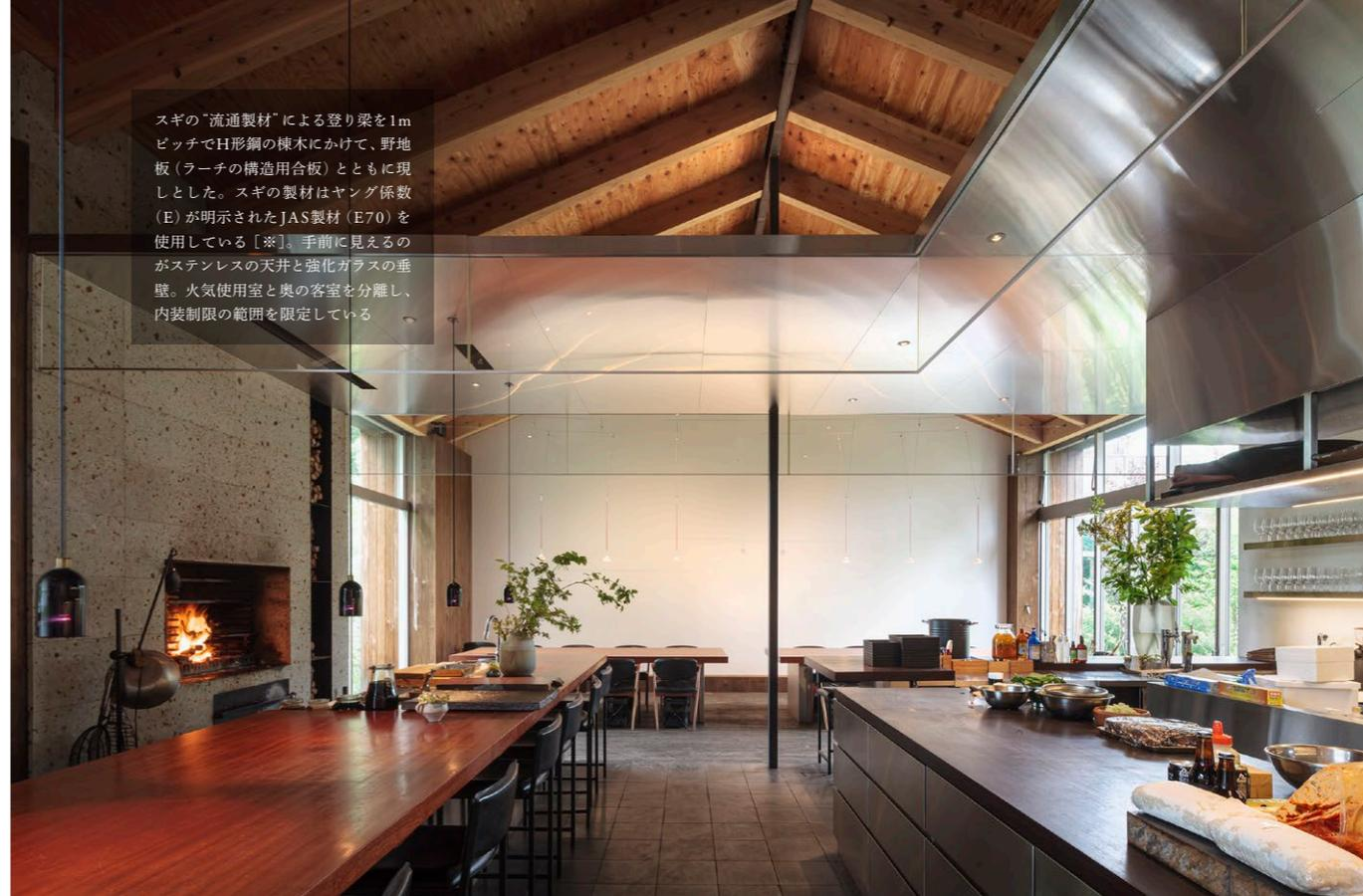
スギの「流通製材」による登り梁を1mピッチでH形鋼の棟木にかけて、野地板（ラーチの構造用合板）とともに現しとした。スギの製材はヤング係数(E)が明示されたJAS製材(E70)を使用している【※】。手前に見えるのがステンレスの天井と強化ガラスの垂壁。火気使用室と奥の客室を分離し、内装制限の範囲を限定している
