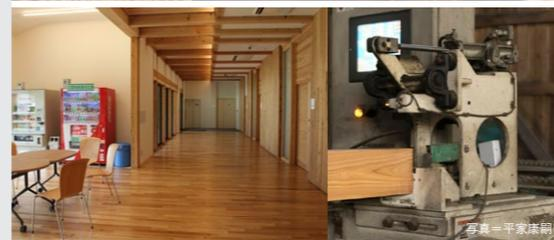
左) コミュニティ棟の廊下。柱と梁はスギ (機械等級区分構造用製材)。右側に見えるのは耐力壁を兼ねるスギのCLT。床材は西子市産のスギを使用。ただし、スギは柔らかくて傷が付きやすいため、スギを圧密加工して硬くし、多くの人が土足で歩行しても傷が付きにくいようにしている
