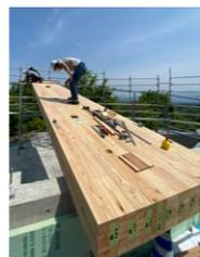
材料費はかかるものの、梁のピッチを細かくするジョイント梁を採用するケースは少ない。ディメンションランバー(ツーバイ材)が利用されることが多い。さらに、梁を一方に連続させ密着させるマッシュホルツという手法もある。施工にやや手間がかかるものの、水平構面を兼ねられるという利点がある。「層ごとにラミナが直交しているCLTよりも高い剛性が得られます」(大野氏)
