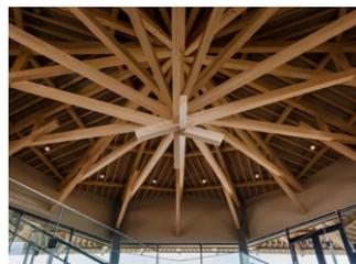
小さな部材を組み合わせた組立梁によって大スパンを飛ばす方法。構造計画は複雑になるものの、国産材の活用に可能性が広がる。「日本平夢テラス」(意匠設計：隈研吾建築都市設計事務所／構造設計：オーノJAPAN)では、小屋組に静岡県産のヒノキ(120×180×4,000mm)の製材を使用。中央の蕪束に対して多角的に梁を架けて(外周部はシザース状)、5.5mのキャンチレバーを実現している
