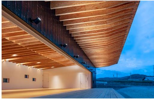
LVLのさらなる特徴は、長尺材(最大12m)の生産に対応できること。加えて、LVLを箱状に組み立てたストレートスキンパネル(組立梁)は水平構面としても使用可能(床倍率換算で倍率15の性能が期待できる)。しかも、LVLの梁とストレートスキンパネルをプレファブ化した「キールム ストレートスキンパネル屋根」を使用すれば、木造軸組による大空間の工期短縮とコストダウンが実現できる。「一場木工所」(意匠設計: HUG・河本組・team Timberize/構造設計: MID研究所/施工: 河本組)では、国産のカラマツ材を用いた「キールム ストレートスキンパネル屋根」を用いて12mスパンの片流れ大空間を実現。LVLならではのアスペクト比の大きい(梁幅50mm/梁成420mm)梁を303mmピッチで配した天井は、LVLならではの意匠[竣工写真=浅川敏]
