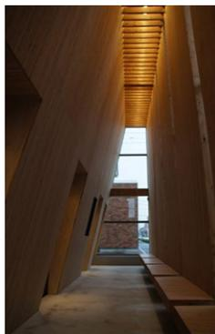
1時間準耐火構造の耐力壁をカラマツのLVL(150mm厚)で設計した木造3階建ての「みやむら動物病院」(意匠設計: ATELIER OPA + ビルディングランドスケープ/構造設計: 桜設計集団/施工: 大和工務店)。耐力壁の性能を壁倍率換算で想定すると、倍率20以上の性能が期待できるとい
