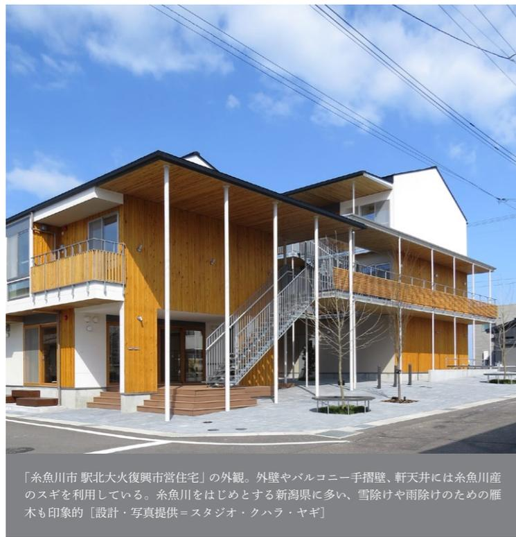
「糸魚川市 駅北大火復興市営住宅」の外観。外壁やバルコニー手摺壁、軒天井には糸魚川産のスギを利用している。糸魚川をはじめとする新潟県に多い、雪除けや雨除けのための雁木も印象的 [設計・写真提供=スタジオ・クハラ・ヤギ]
