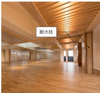
「やはた幼稚園 保育ルーム」(設計: ビルディングランドスケープ)では、薬液を含浸しやすいスギのLVLで被覆した1時間耐火構造の柱を4本採用。国産スギの製材(160mm角)にLVL(60mm厚)を被覆した280mm角の独立柱。表面は溶剤系ウレタンクリア塗装で仕上げた
