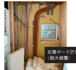
さまざまな給排水管や電気配線が引き回されるPSも耐火被覆の内側に設ける。欠損が生じる場合には、パテなどで被覆する。PSの内側には壁下地としての石膏ボード(12.5mm厚)を張る
