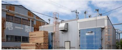
写真右が高温蒸気式減圧乾燥機。機械等級区分構造用製材の基準である、仕上げ材（乾燥後修正挽きまたは材面調整を行い、寸法仕上げした製材）については含水率20%以下（SD20）にする必要があり、山長商店ではこの基準に準拠した製材品を出荷している
