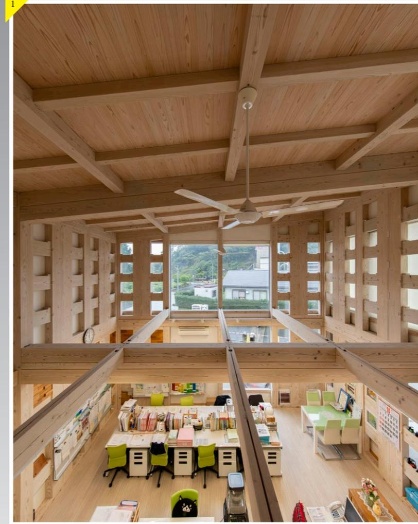
「荒川木材店道作工場事務所」は、福島県いわき市で製材業を営む材木店の事務所である。木造2階建てで、梁間約7.2m×桁行約22mの羊羹型の形状。柱・梁・耐力壁に、地元で生産されたスギの大断面製材（無垢材）を用い、そのすべてをインテリアの要素として活用しているのが大きな魅力である。大断面製材は、いずれも、ヤング係数と含水率が明確に表示された機械等級区分構造用製材（JAS製材）である。
