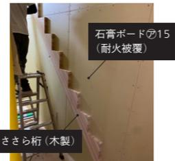
ささら桁を取り付けた後の階段室。耐火被覆となる石膏ボードの内側にささら桁を取り付けているので、耐火被覆の欠損が生じていない
