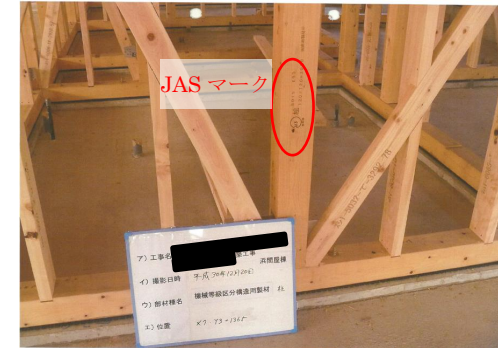
写真6 施工後の写真(トラス材の例)
