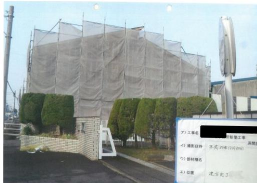
写真7 建て方終了後の全景写真の例
