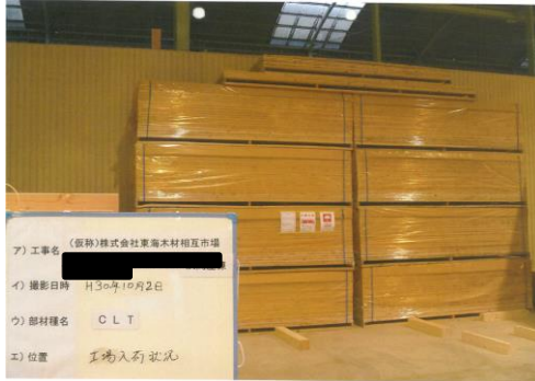
写真4 材料検収写真(CLTの例) （※写真は現場のストックヤード）
