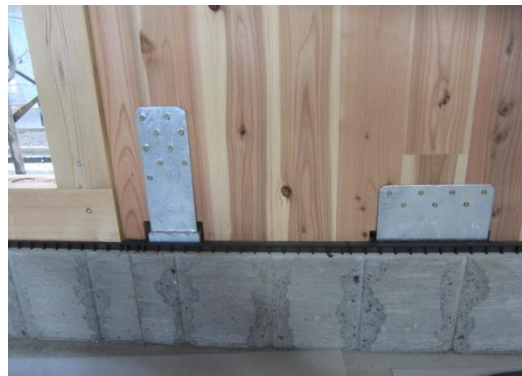
写真8 CLT耐力壁下部の引張金物とせん断金物の例
