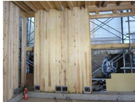
写真5 施工後の写真(CLT耐力壁)
