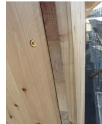
写真9 CLT壁相互のビス接合の例
